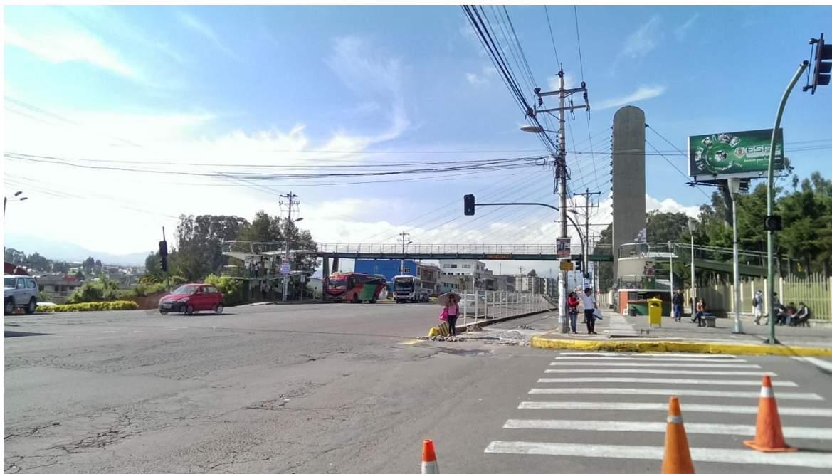
Figura 14. Parada con rampas de acceso y continuidad en acera
