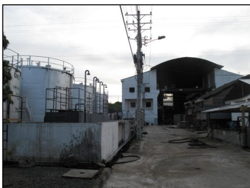
Foto 9 Central Termoeléctrica Miraflores
