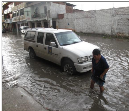
Fototo 6 Problemas de alcantarillado en zona urbana
