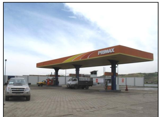
Foto 14 Estación de Servicio
