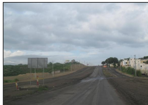
Foto 4 Camino pavimentado en mantenimiento
