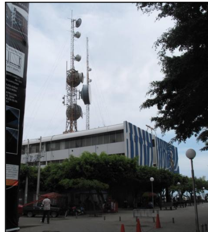
Foto 8 Central Telefónica CNT Manta
