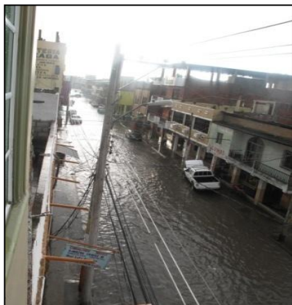
Foto 5 Problemas de alcantarillado en zona urbana
