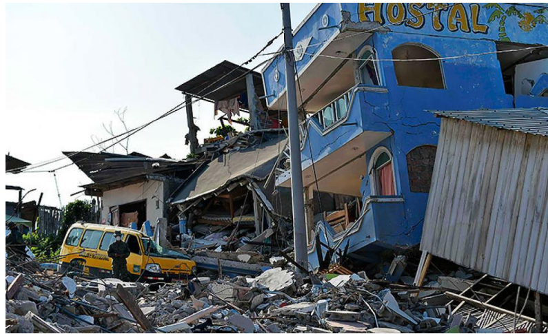
Figura 5: Desastre Natural Terremoto - 16 de Abril del 2016
