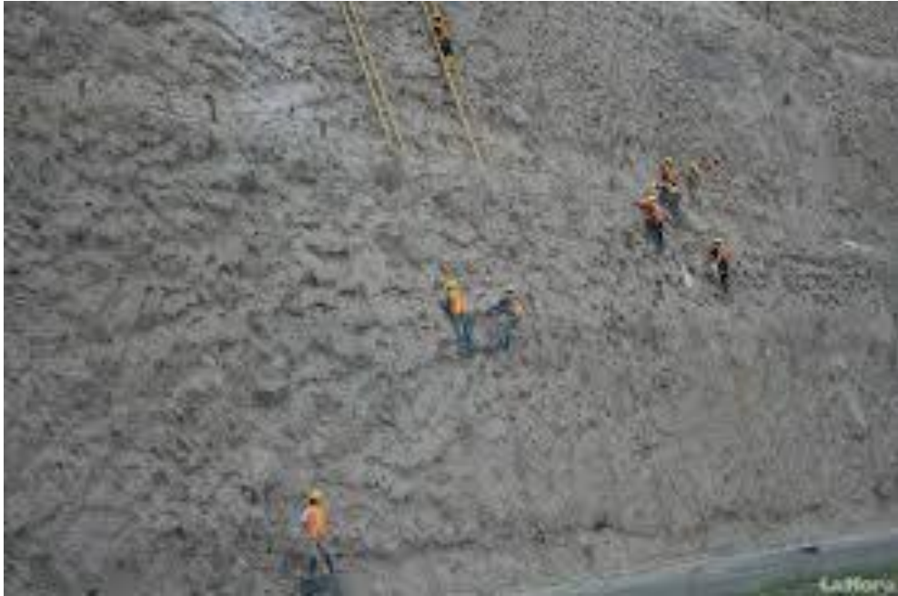
Ilustración 4.46. Ejemplo de hormigón lanzado y anclajes.
