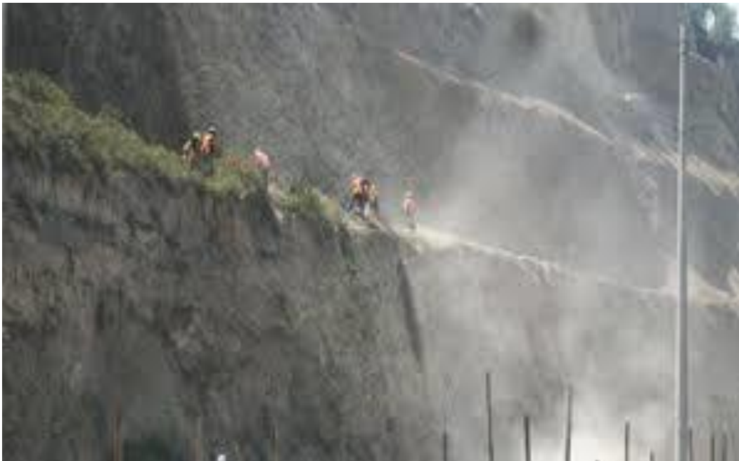
Ilustración 4.47. Ejemplo de hormigón lanzado y anclajes.
