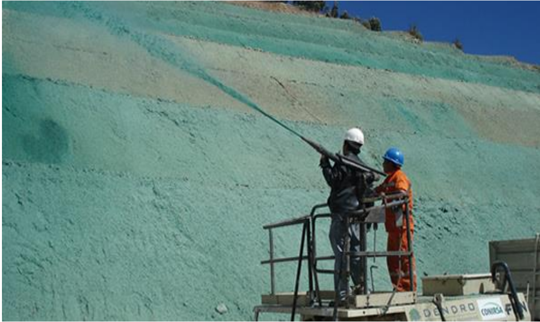
Ilustración 4.42. Ejemplo de hidrosiembra en un talud.
