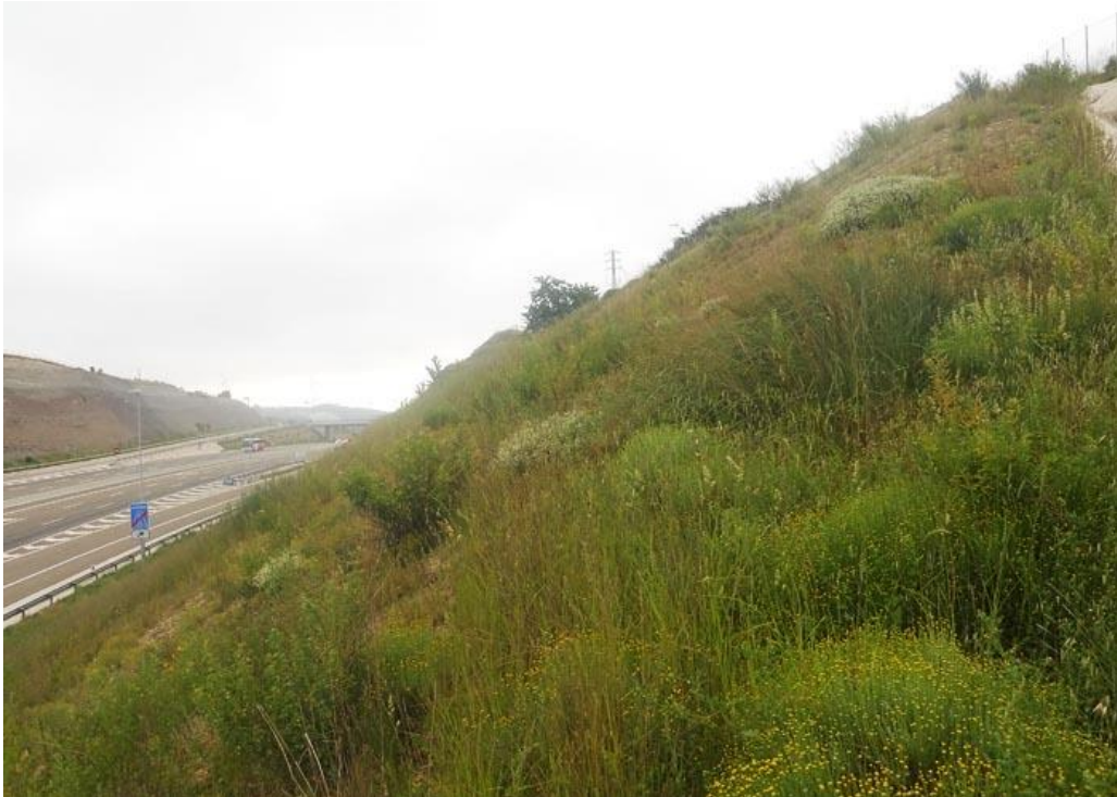
Ilustración 4.40. Ejemplo de recubrimiento vegetal con geomalla anclada.
