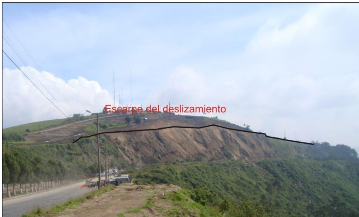
Ilustración 1.5. Vista del deslizamiento del talud de la Forestal (2011)
