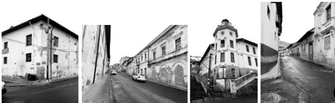
Ilustración 6: Inmuebles en estado de abandono
