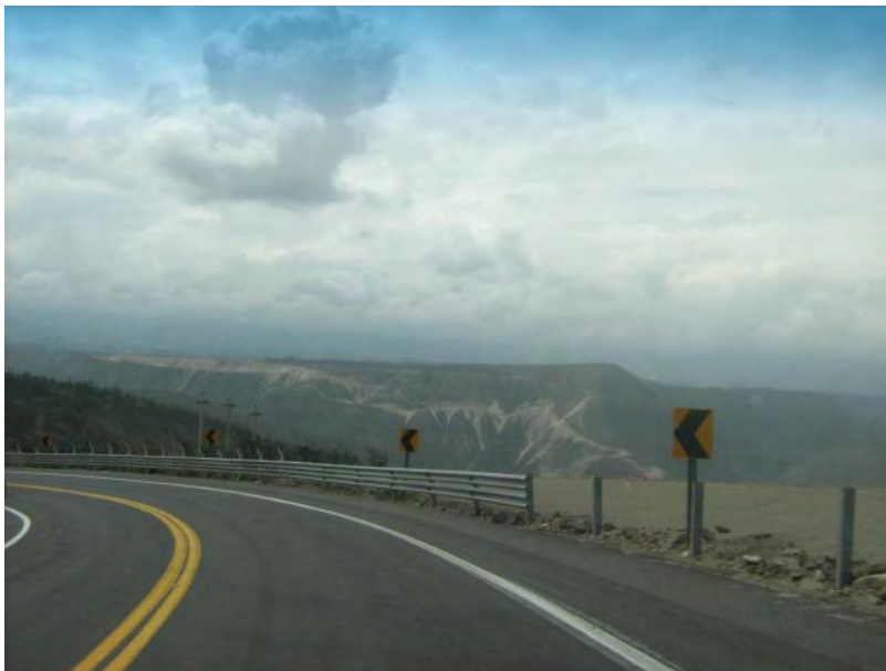
Fotografía N° 2: Construcción de Ruta Collas
