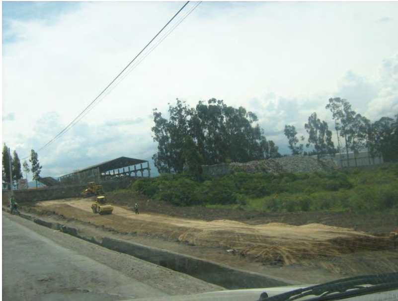
Fotografía N° 9: Ampliación de la E35 en la zona de Pifo
