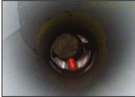
Fotografía 6: Válvulas de aire
