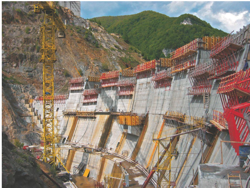
Fotografía I. Construcción de pared y esclusas de una presa.
