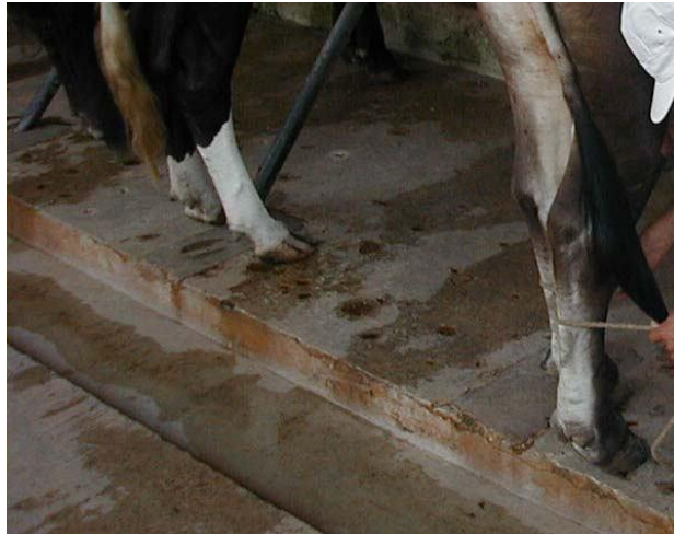
Gráfico13. Drenaje interno ubicado atrás de la posición que ocupan las vacas al ordeñarse. (Alvarado, H.2010)
