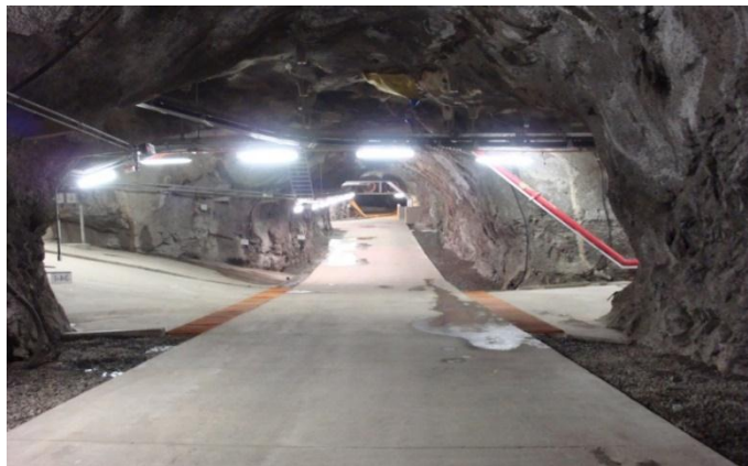
Foto 1.1. Ingreso casa de máquinas hidroeléctrica San Francisco.
