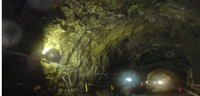
Foto 1.3. Túnel ventana 4 Central Hidroeléctrica San Francisco.
