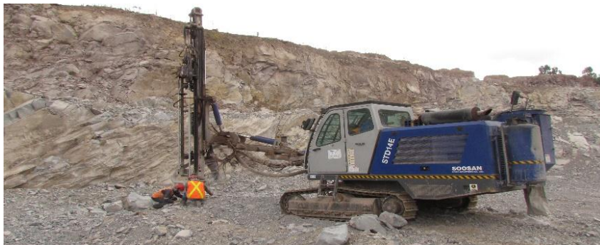
Foto 2.4. Perforaciones en Macizo rocoso , longitud de anclaje 90 cm.
