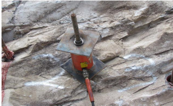
Foto 2.5. Prueba de extracción de pernos.
