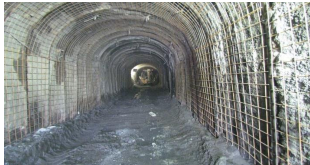
Foto 1.26. Cerchas Revestidas con malla electrosoldada central hidroeléctrica la Victoria.
