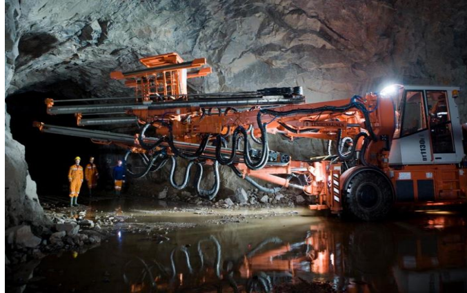
Foto 1.7. Excavación de casa de máquinas con Jumbo.
