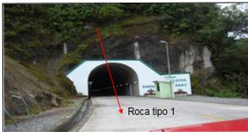
Foto 1.12. Acceso a Casa de Maquinas Central Hidroeléctrica San Francisco.
