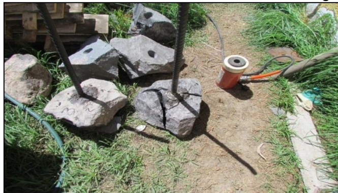
Foto 2.2. Control de calidad de resina realizado con un gato hidráulico
