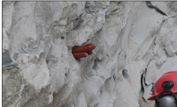
Foto 1.24. Colocación de cartuchos de resina en una perforación de 90mm.
