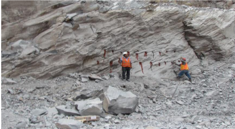
Foto 2.3. Perforaciones en Macizo rocoso, longitud de anclaje 30, 45 cm.
