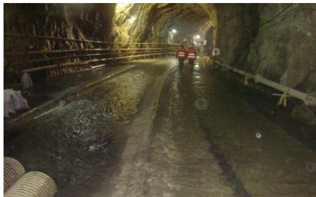
Foto 1.4. Túnel de Carga Central Hidroeléctrica San Francisco.
