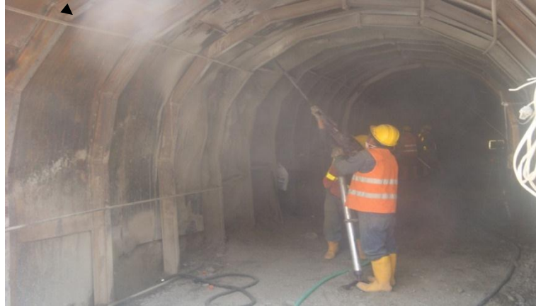
Foto 1.10. Modificación de trazado de la vía de Ferrocarril río Chan Chan..
