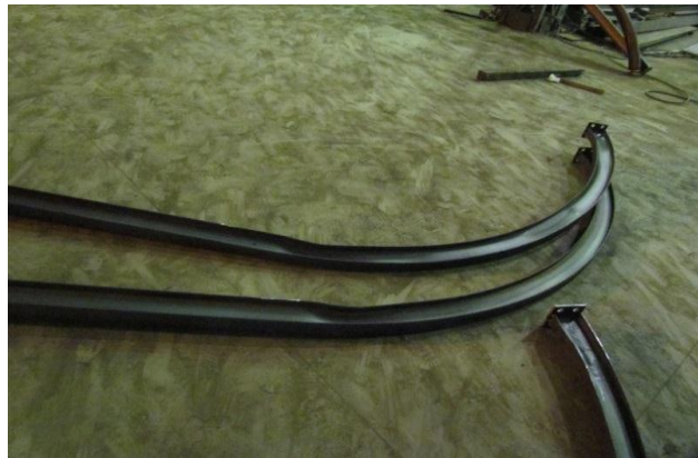
Foto 1.25. Cercha metálica de 2 tramos IPN 100 Central hidroeléctrica la Victoria.
