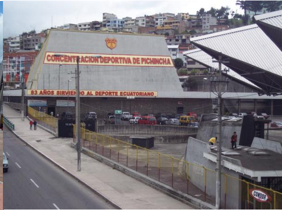
Fuente: Eduardo Narváez Muro de contención
