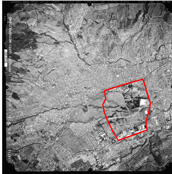
Vista Aérea Quitumbe 1991
