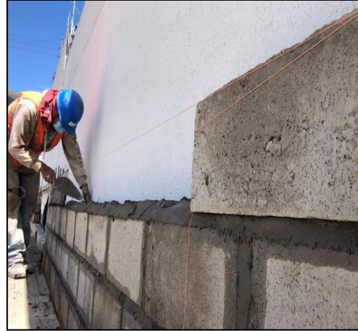
Ilustración 23 Colocación de “maestras” y mortero en capa horizontal para filas superiores
