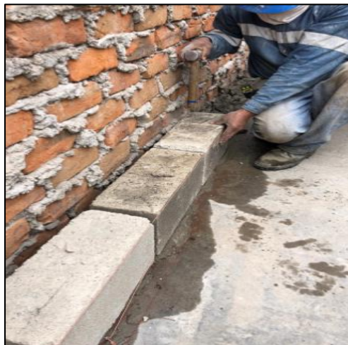
Ilustración 19 Finalización de primera fila de bloque
