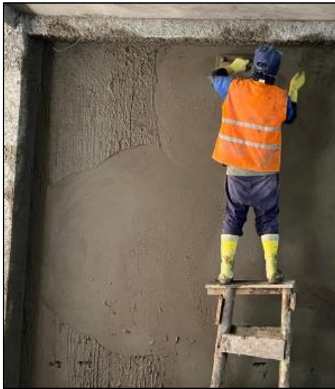
Ilustración 38 Uso de paleta de madera
