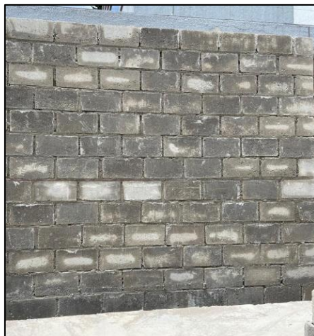
Ilustración 30 Pared de mampostería de bloque finalizada
