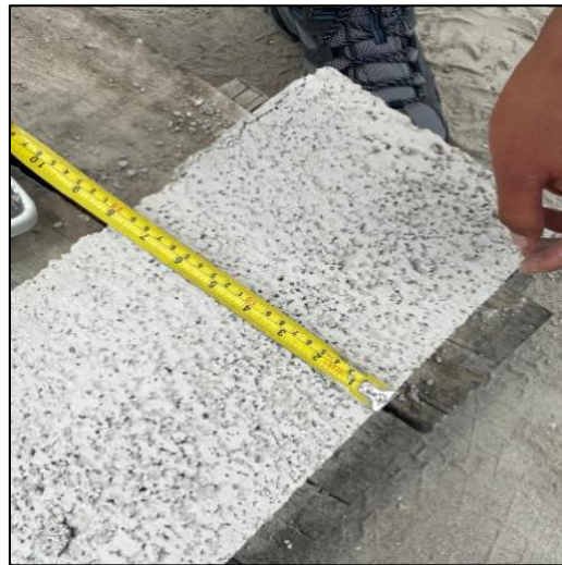
Ilustración 4 Medición de profundidad de bloque
