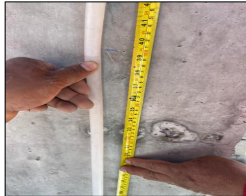
Ilustración 14 Nivelación con manguera
