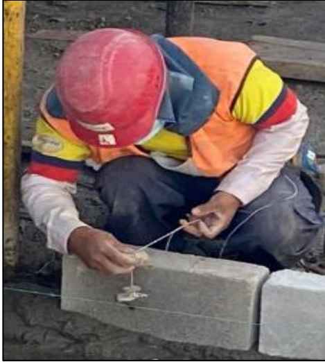
Ilustración 17 Nivelación con plomada
