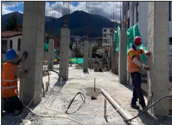
Ilustración 13 Nivelación con manguera
