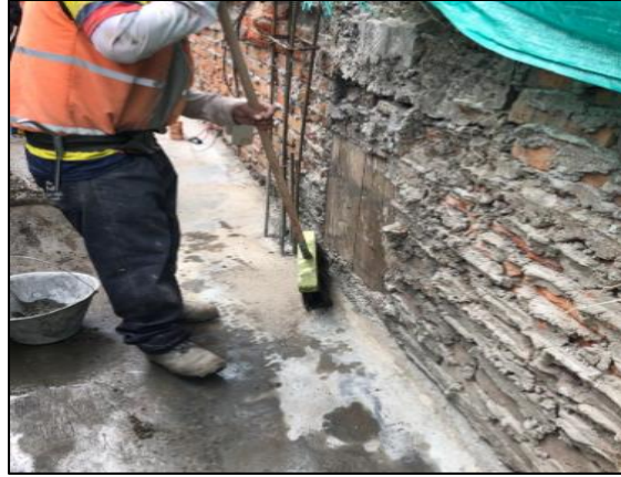
Ilustración 12 Limpieza de la superficie
