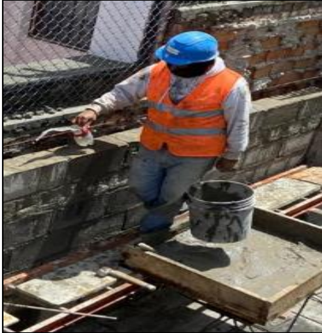
Ilustración 22 Humedecimiento de superficie previo a colocación de filas superiores
