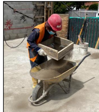
Ilustración 7 Tamizado en obra
