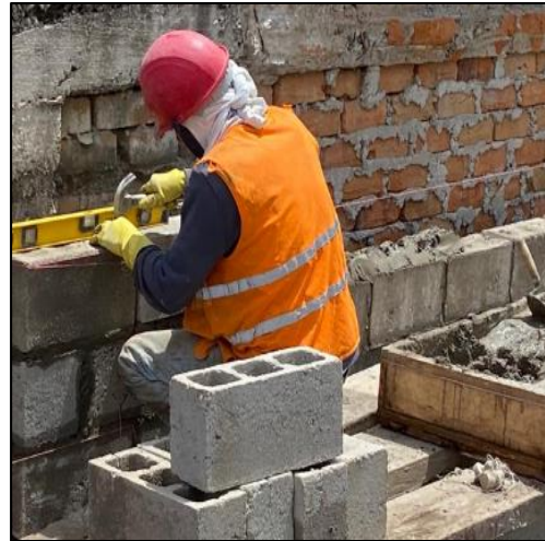
Ilustración 29 Control de alineación horizontal con nivel de mano
