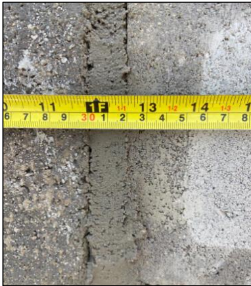
Ilustración 20 Medición de capa vertical de mortero para adherencia
