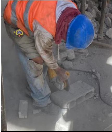
Ilustración 26 T Corte de bloque con amoladora
