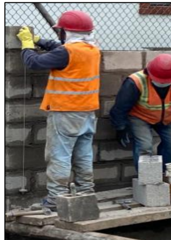
Ilustración 25 Verificación de verticalidad en filas superiores con plomada
