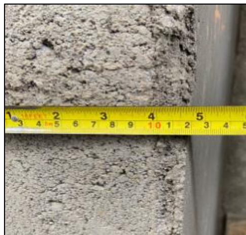
Ilustración 41 Evidencia de espesor de capa de enlucido terminado
