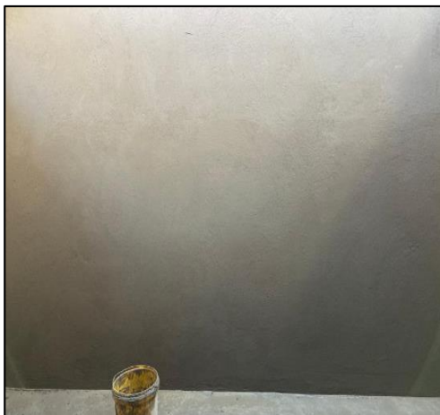
Ilustración 40 Pared de mampostería de bloque enlucida
