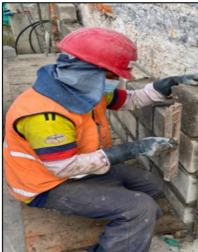
Ilustración 24 Verificación de verticalidad en filas superiores con nivel de mano
