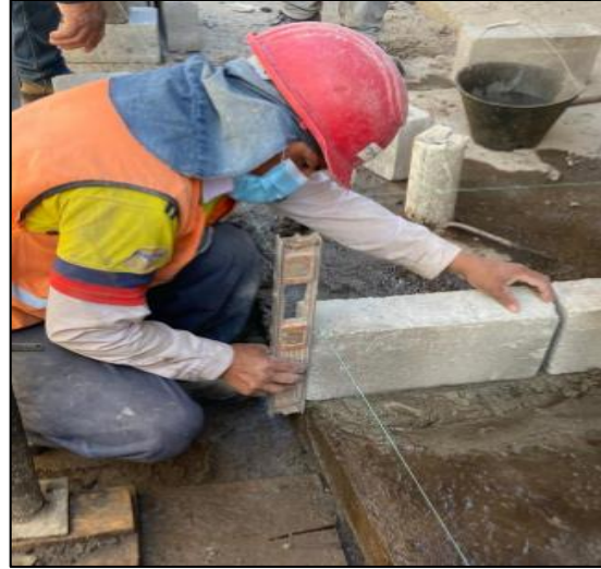
Ilustración 18 Nivelación con nivel de mano
