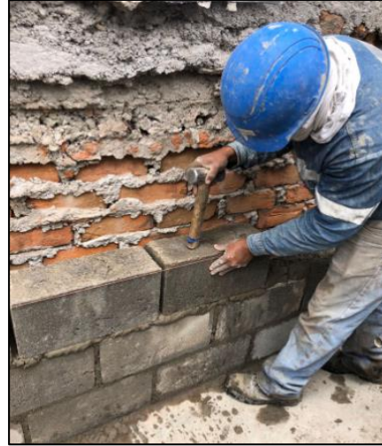
Ilustración 27 Colocación de bloques en filas superiores
