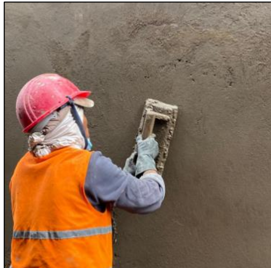
Ilustración 39 Uso de paleta de madera
