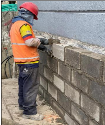
Ilustración 28 Colocación de capa de mortero vertical para pegado de bloques en filas superiores
