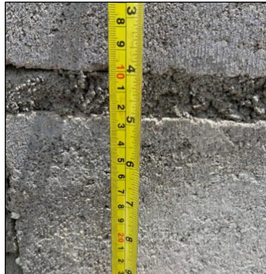
Ilustración 21 Medición de capa horizontal de mortero para adherencia
