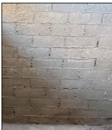
Ilustración 31 Pared de mampostería de bloque luego de 24 horas
