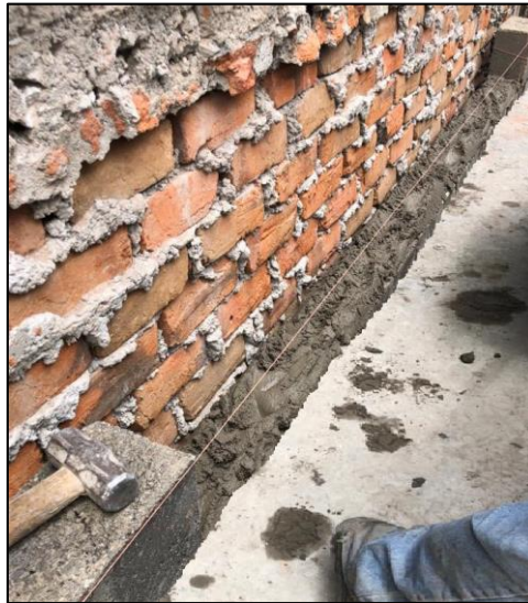
Ilustración 16 Colocación de “maestras” y alineación horizontal
