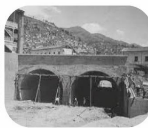
Túnel de San Diego en construcción Fuente: Quito, Ayer y Hoy
