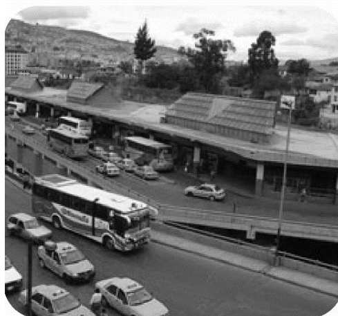
Figura 27: Vista del antiguo Terminal Terrestre Cumandá
