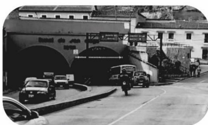
Túnel de San Diego finalizado Fuente: Recordando a Quito
