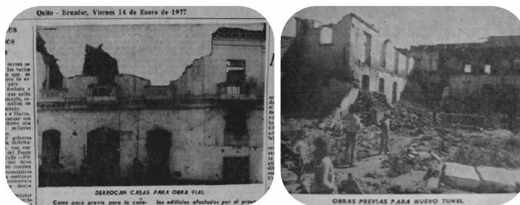
Figura 33: Casas demolidas para la construcción de Av. Occidental en San Diego
