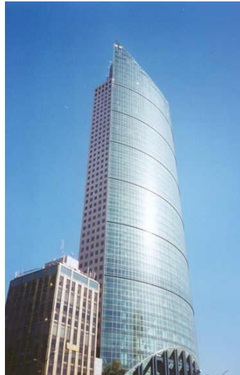
Foto 3 Torre Mayor, México
