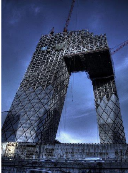
Foto 1 Construcción de la CCTV (TV China)
