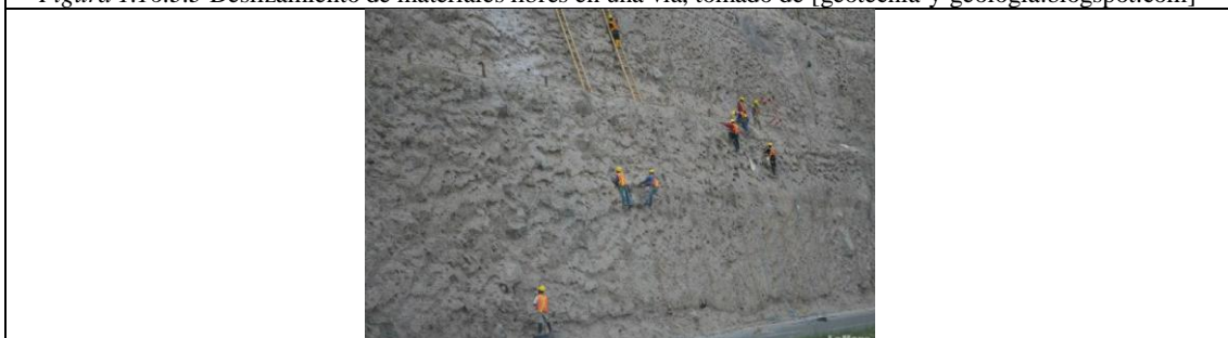
Figura 1.16.3.4 Recubrimiento de Talud, Paso lateral Ambato, [Diario la Hora, Jueves, 22 de Noviembre de 2012, Diario la Hora].
