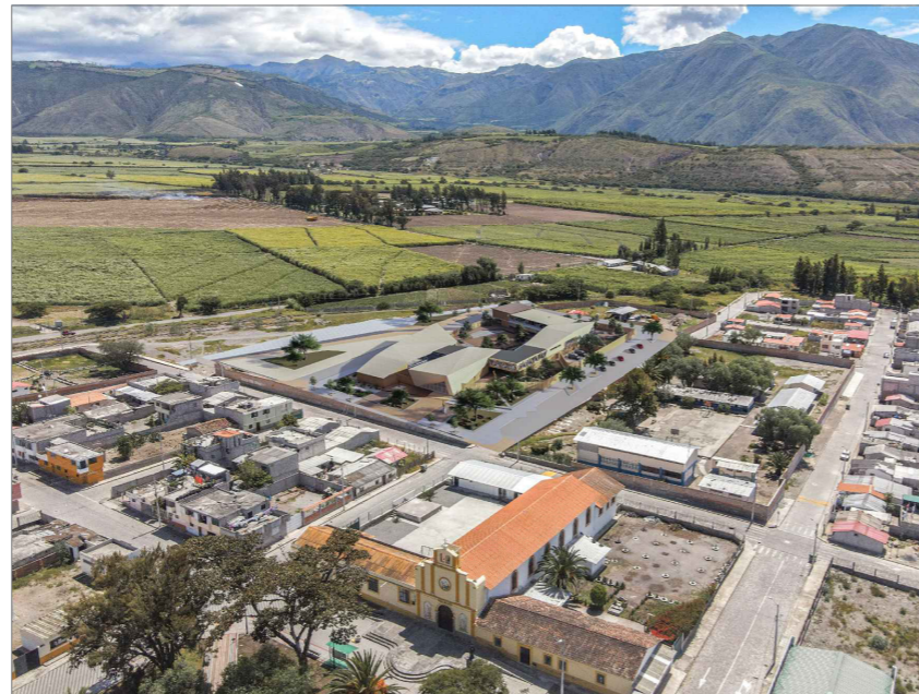
DESPUÉS DE LA INTERVENCIÓN
