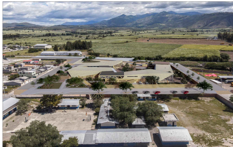
DESPUÉS DE LA INTERVENCIÓN
