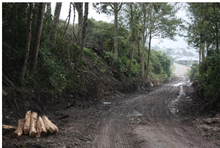
Fotografía 4. Deslaves y lodazales en la vía de acceso al poblado de Oyacachi
