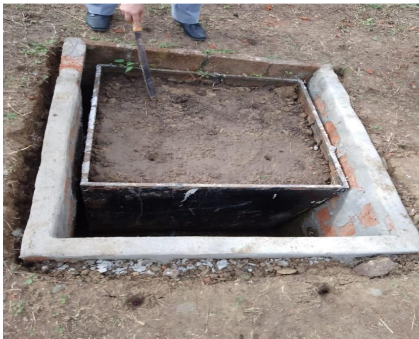
Figura 8: Vainas ubicadas en su lugar
