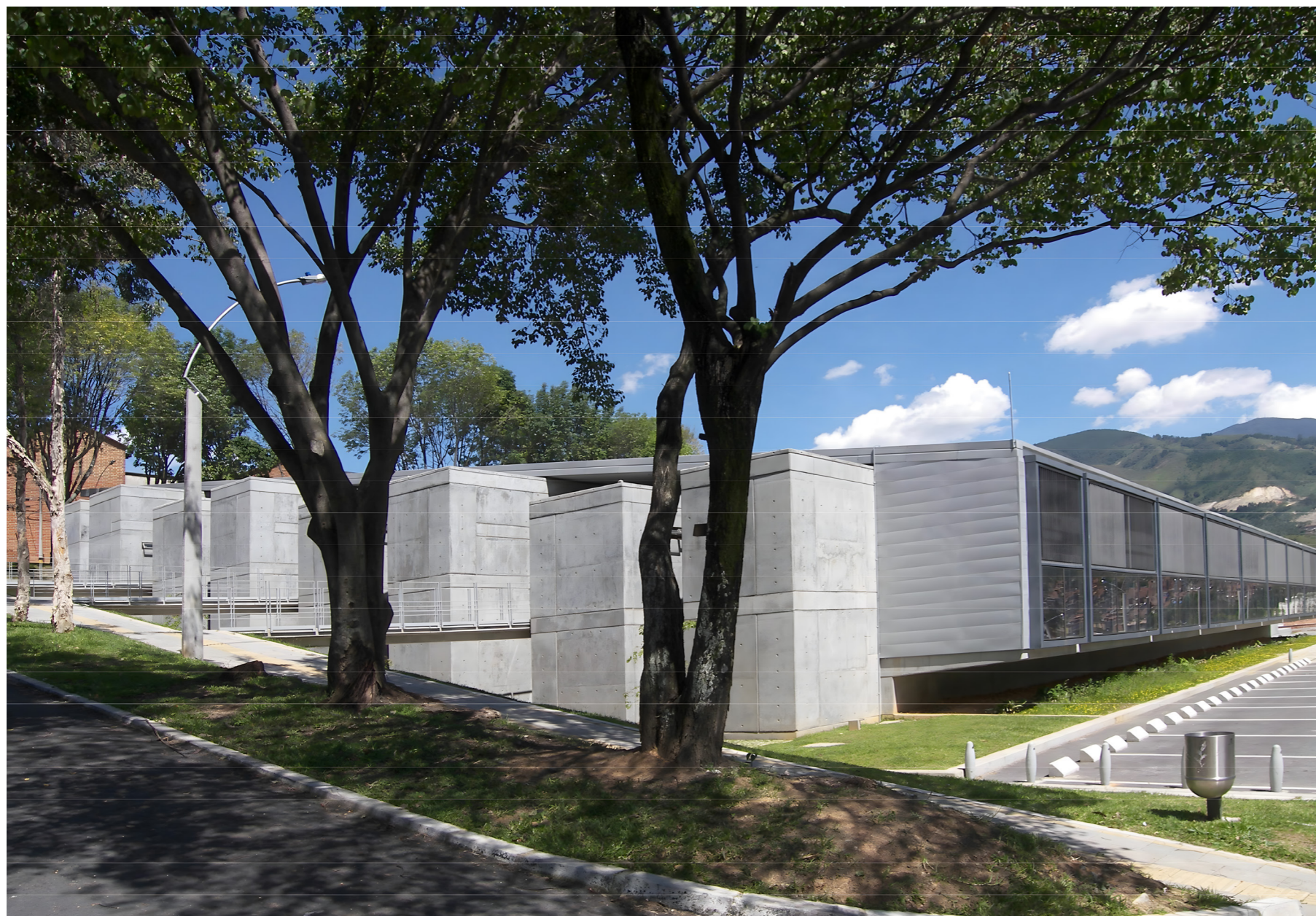
Figura 29: Perspectiva exterior de la Biblioteca San Javier, Medellín, Colombia. Fuente: Arquitectura Panamericana, 2008.
