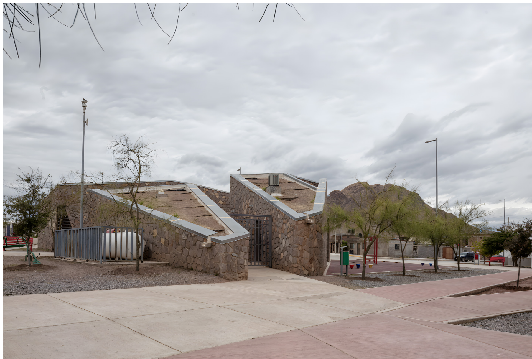
Figura 33: Perspectiva del centro comunitario Vistas de Cerro Grande Fuente: Archdaily, 2011.
