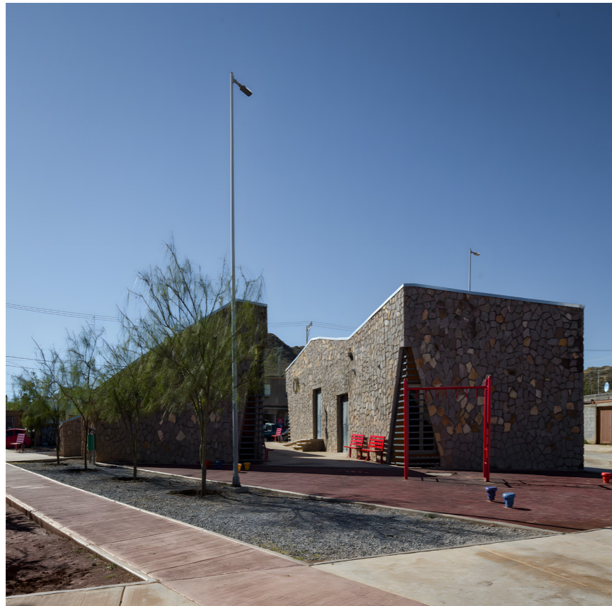
Figura 35: Perspectiva exterior del centro comunitario Vistas de Cerro Grande. Fuente: Archdaily, 2011.
