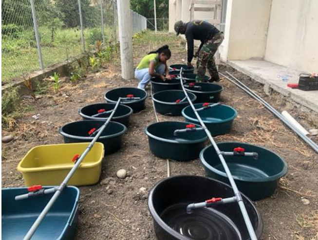
fotografía 2: Preparación de materiales y simulación de construcción del sistema RAS, para visualizar como se ven distribuidas en el espacio de trabajo.
