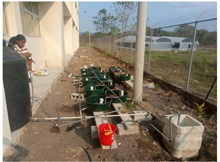
fotografía 3: Construcción terminada del S.A.
