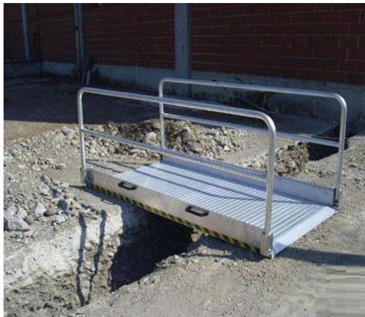
[Imagen de cubierta protecciones colectivas. Recuperado de Edificio Estrella IX, https://www.interempresas.net/FotosArtProductos/P102830.jpg
