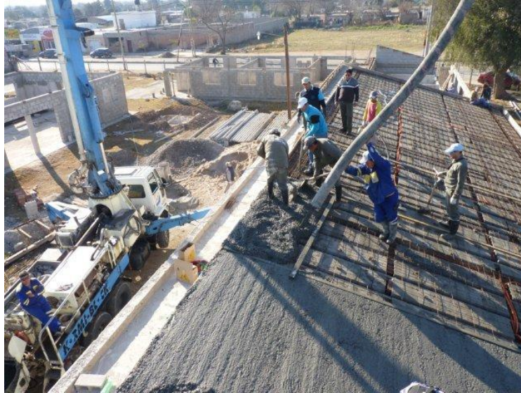
[Imagen de fundido con tubería de vertido de hormigón]. http://i.ytimg.com/vi/ZzPhyujh4r0/hqdefault.jpg
