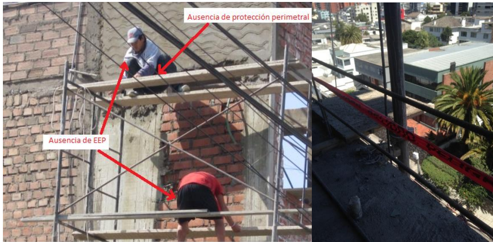
[Imágenes de redes de protección perimetral]. Recuperado de Edificio Estrella IX
