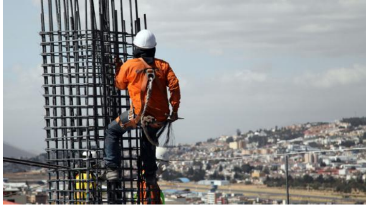
[Imagen de armado de columnas. Recuperado de Edificio Estrella IX
