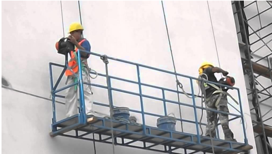
[Imagen de trabajadores sobre andamios colgante. Recuperado de https://i.ytimg.com/vi/C-cQ5UYMChw/maxresdefault.jpg
