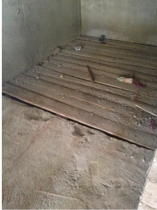
[Imagen de cubierta en abertura de losa. Recuperado de Edificio Estrella IX
