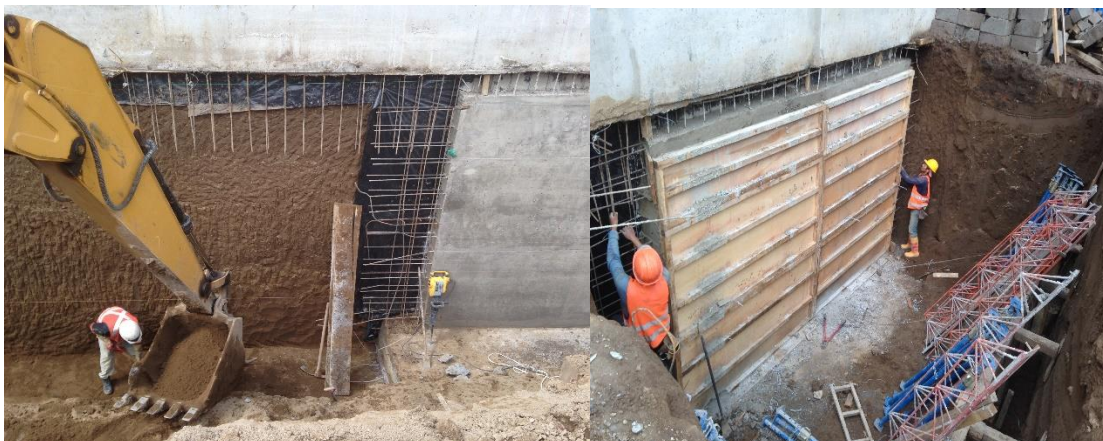
[Imagen de excavación, materiales sobre pisos]. Recuperado de Edificio Tiziano
