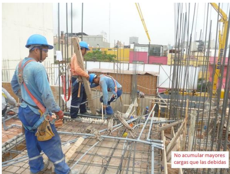
[Imagen de armado de muros]. Recuperado de Edificio Tiziano
