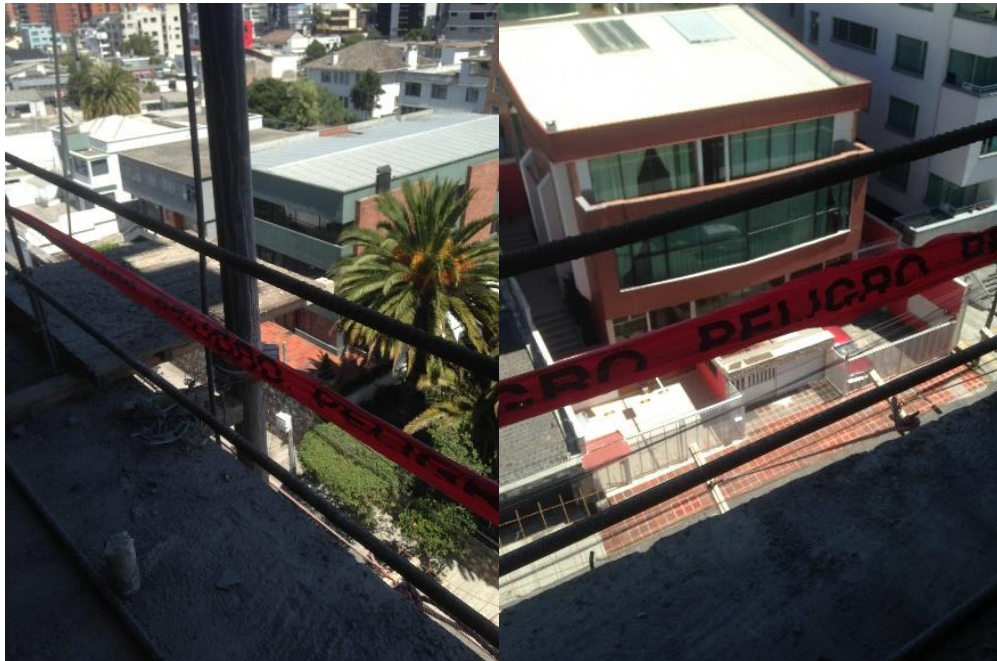
[Imágenes de redes de protección perimetral]. Recuperado de Edificio Estrella IX
