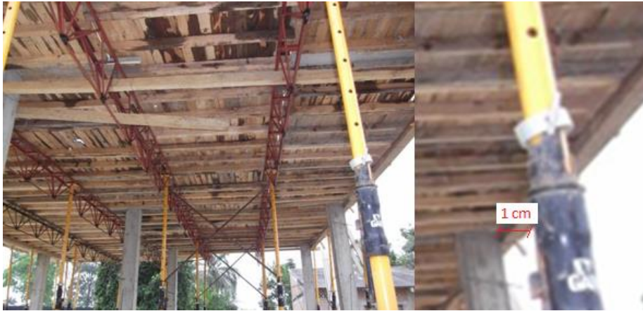
[Imágenes de encofrado de losa]. Recuperado de construcción casa legarda
