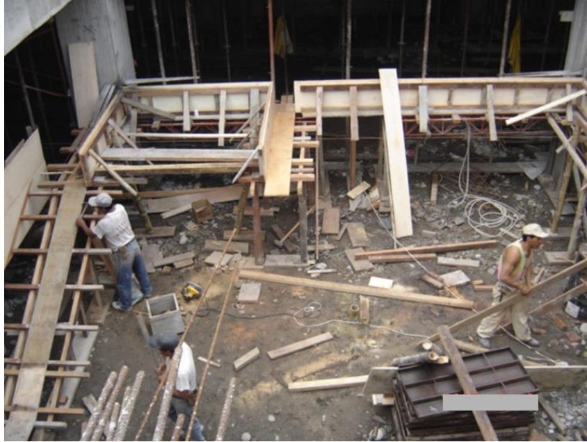
[Imágenes de área de encofrados]. Recuperado de construcción casa legarda
