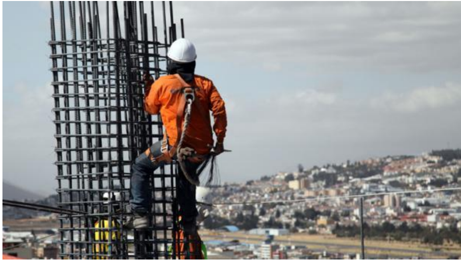
[Imagen de armado de columnas. Recuperado de Edificio Estrella IX
