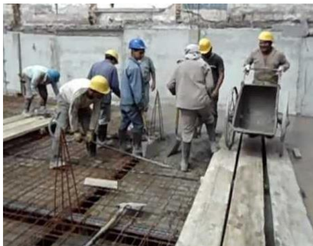
[Imagen de limpieza y orden en fundición de losa]. http://i.ytimg.com/vi/ZzPhvujh4r0/hqdefault.jpg
