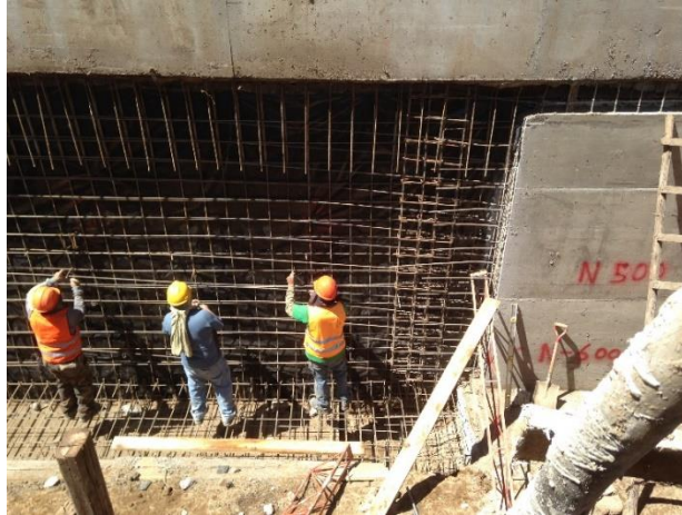
[Imagen de excavación profundidades mayores a 5 m. Recuperado de Edificio Tiziano
