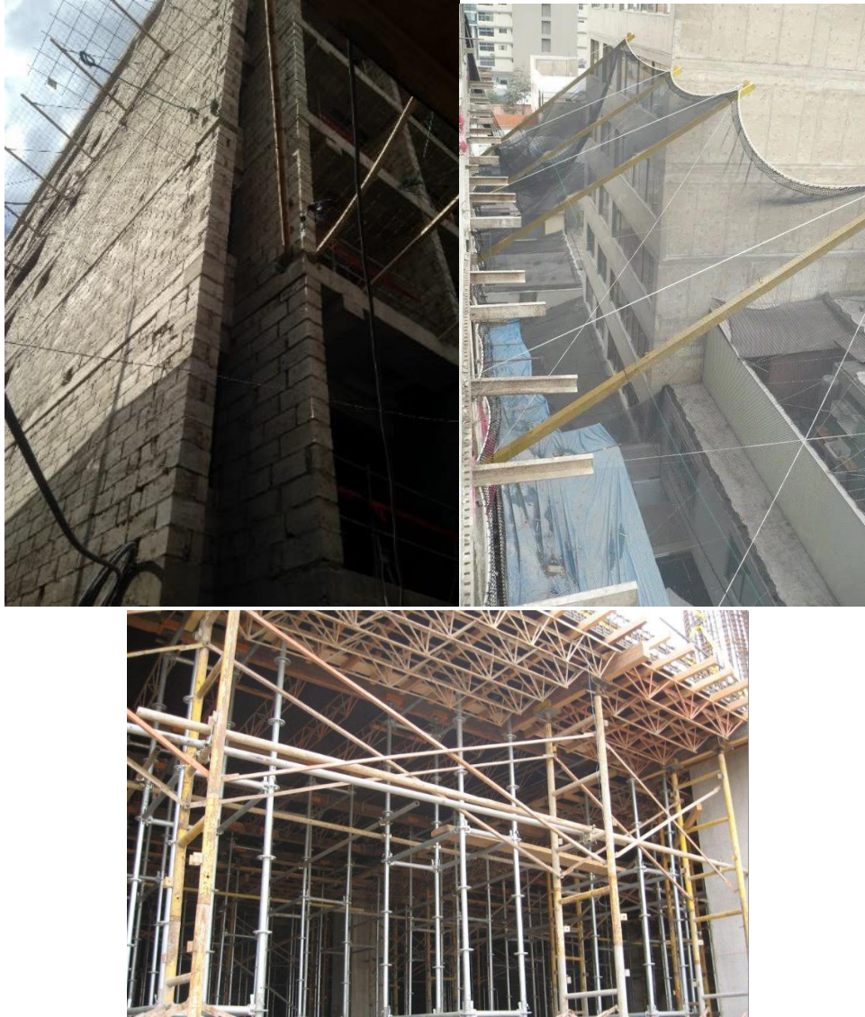
[Imagen de cubierta protecciones colectivas. Recuperado de Edificio Estrella IX, https://www.interempresas.net/FotosArtProductos/P102830.jpg
