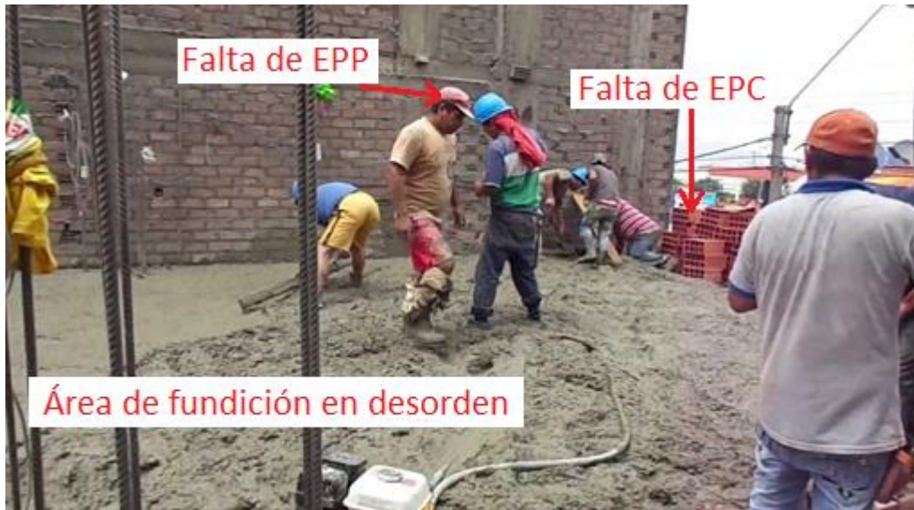
[Imagen de fundición de losa]. http://i.ytimg.com/vi/A_I5I0NDpsg/maxresdefault.jpg
