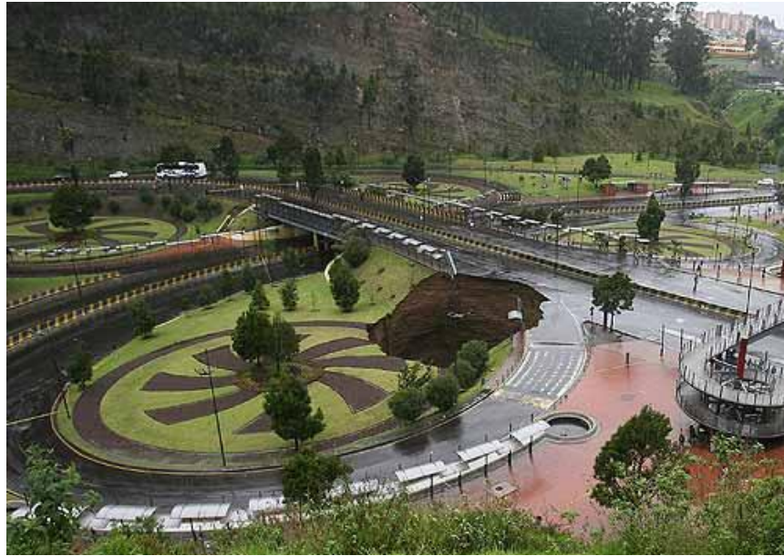
Fotografía 1: Hundimiento en el Trébol
