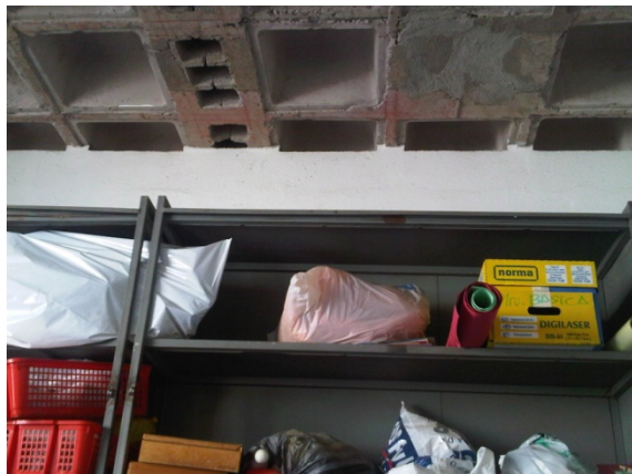
Bodega entre dos aulas (techo de losa con casetones).
