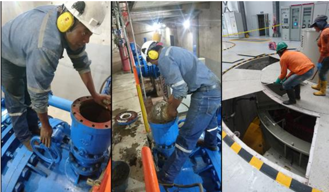
ILUSTRACIÓN 38: FOTO TOMADA EN LA CENTRAL HIDROELÉCTRICA "TOPO" INSPECCIÓN Y LIMPIEZA VÁLVULA DE AIRE, DESMONTAJE DE ESTRUCTURA DE PROTECCIÓN SUPERIOR.
