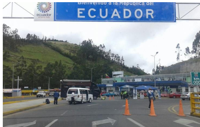
Ilustración 20: Instalaciones de Control a pasajeros Rumichaca Fuente: Elaboración Propia
