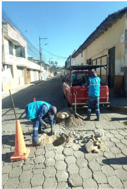
Figura 54 Reparación tapa de alcantarillado
