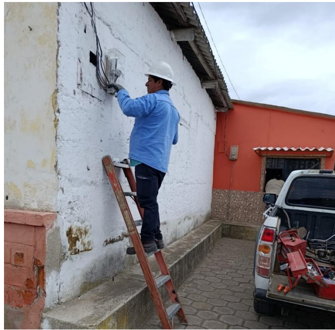
Figura 56 Mantenimiento medidor residencial
