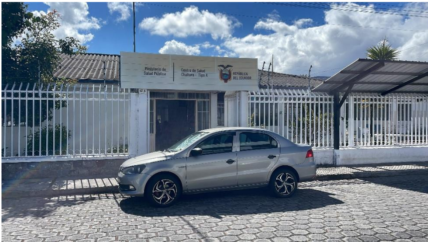
Figura 60 Centro de Salud de Chaltura Tipo A
