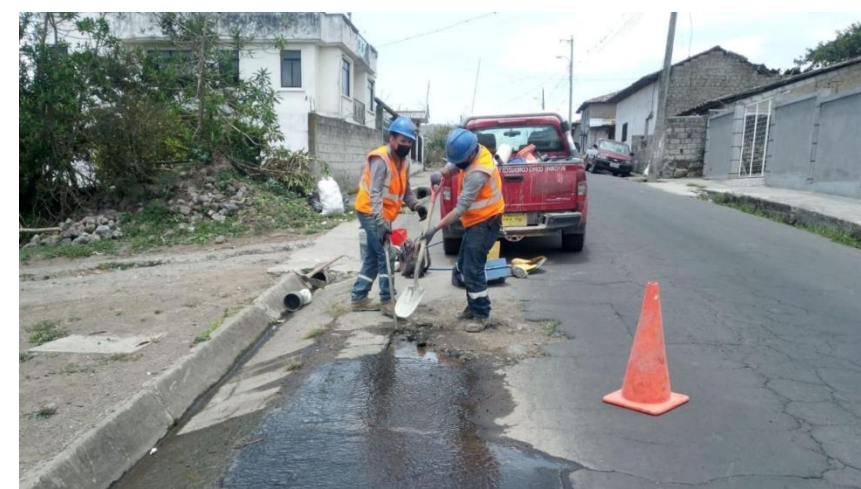
Figura 52 Reparación fuga de red agua potable
