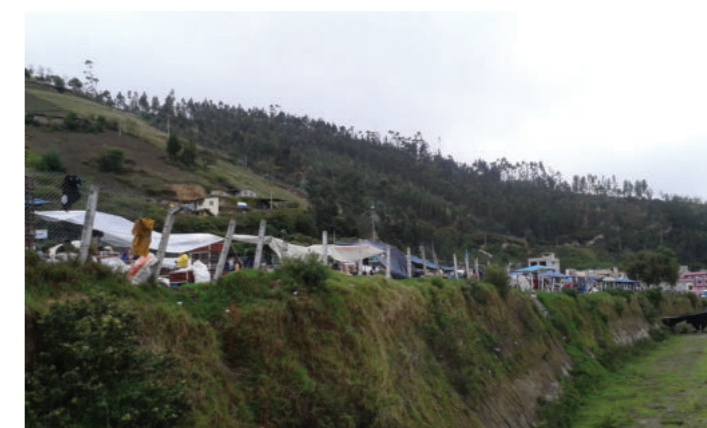
Figura 205. Plataforma propia del terreno, Sector Yanayaku - Otavalo Fuente: Fernanda Dávila, 2016
