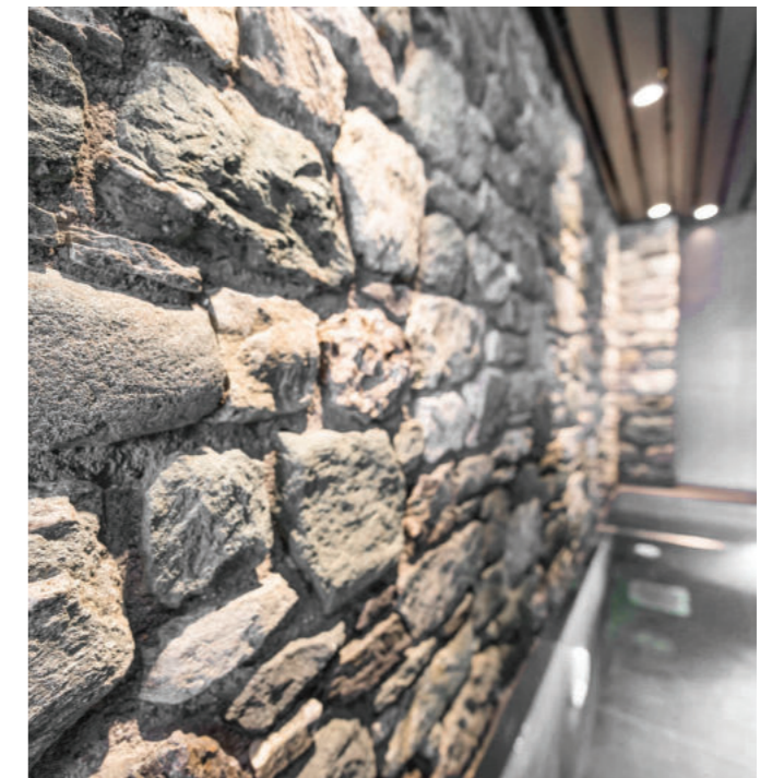
Figura 210. Textura de piedra sobre pared Fuente: http://hotel-nendaz-4-vallees.hotelmix.it/ Hotel Nendaz, 2007
