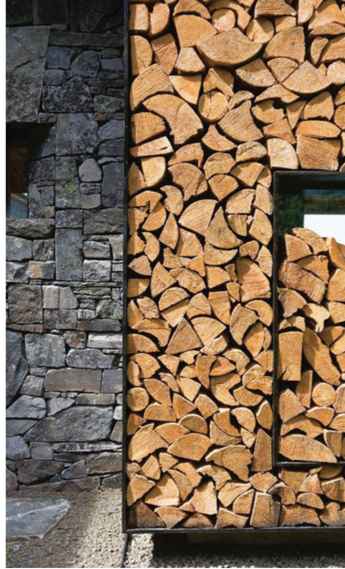
Figura 237. Muro con trozos de madera
