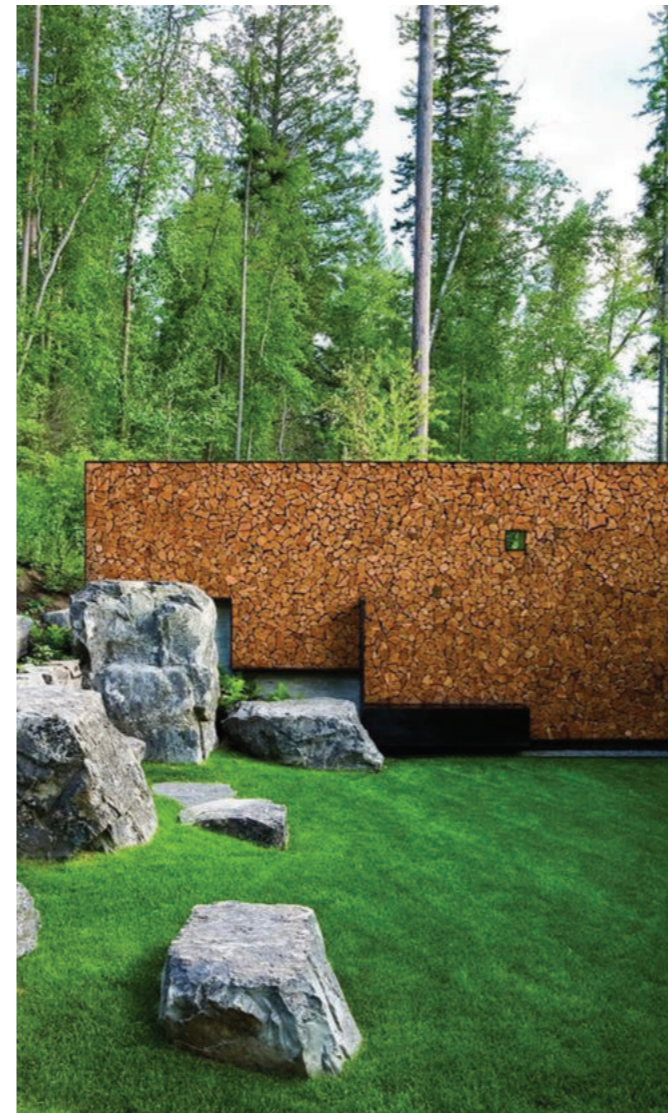
Figura 238. Muro con trozos de madera
