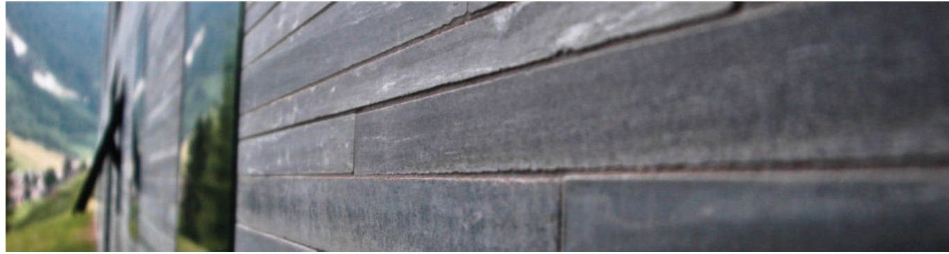
Figura 97. Vals cuarcita, material utilizado para la construcción de la Termas de Vals - Suiza Fuente: http://www.graymatters.gatech.edu/2011/02/15/peter-zumthor-therme-vals/ Shota Vashakmadze , 2011
