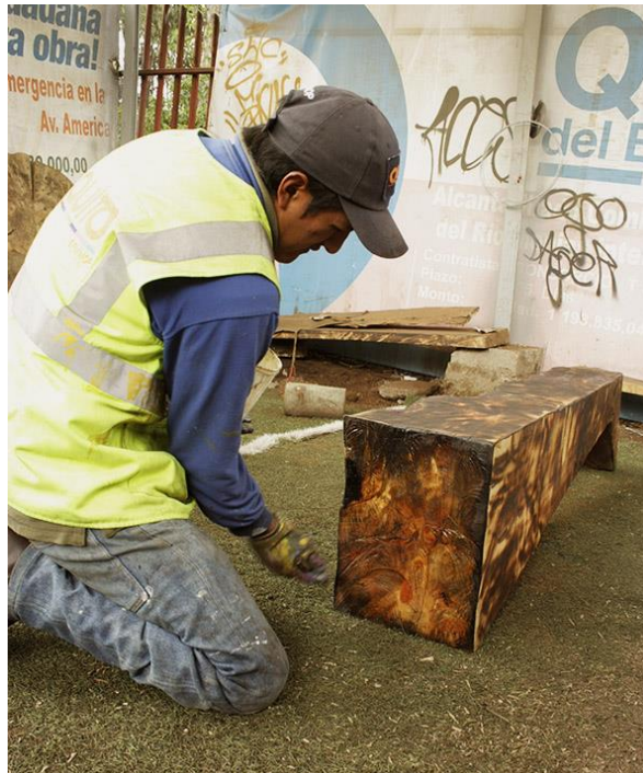
Imagen 15: Impermeabilización de la madera
