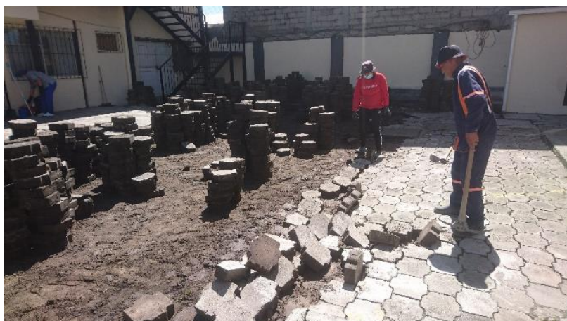
Ilustración 7. Adoquín reciclado. Fuente: Jonathan Enríquez.
