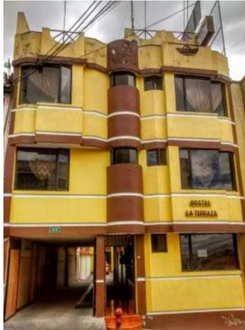
Ilustración #1 Elaborado por: Patricio Ortega Vista frontal del edificio
