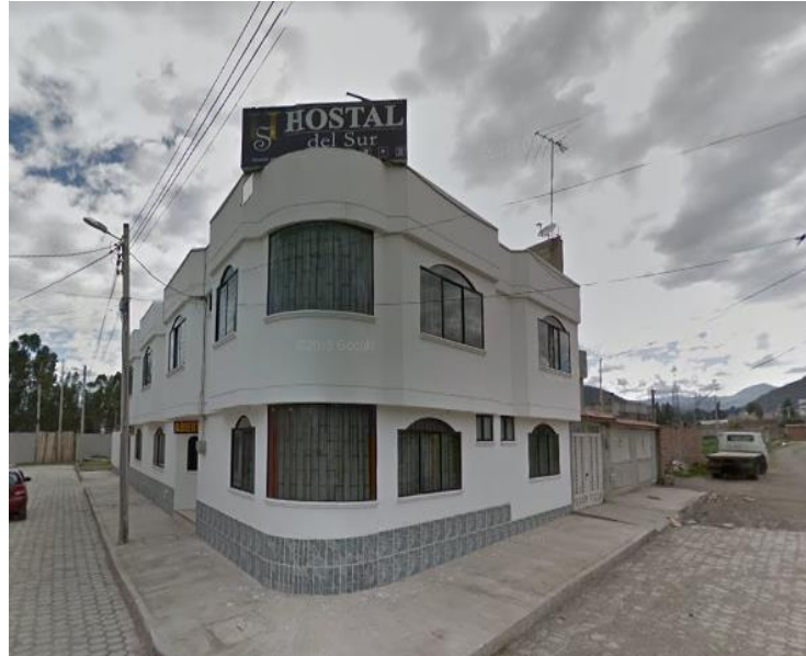
Foto 4.8 - Vista de edificaciones en la Zona 2, Hostal del Sur.
