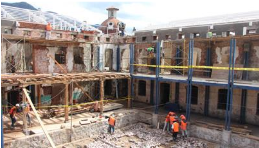
Figura 9. Avanzan los trabajos de rehabilitación. Fuente: Ministerio de cultura y patrimonio, 2014
