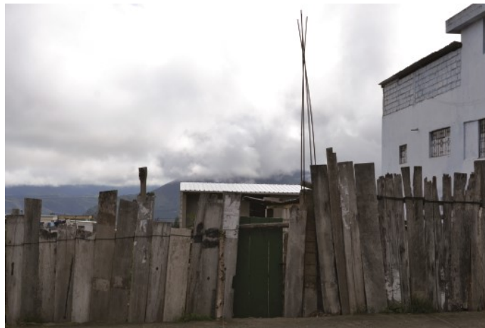
Fotografía 5 Muros Fuente: Dillon Julián, 2013
