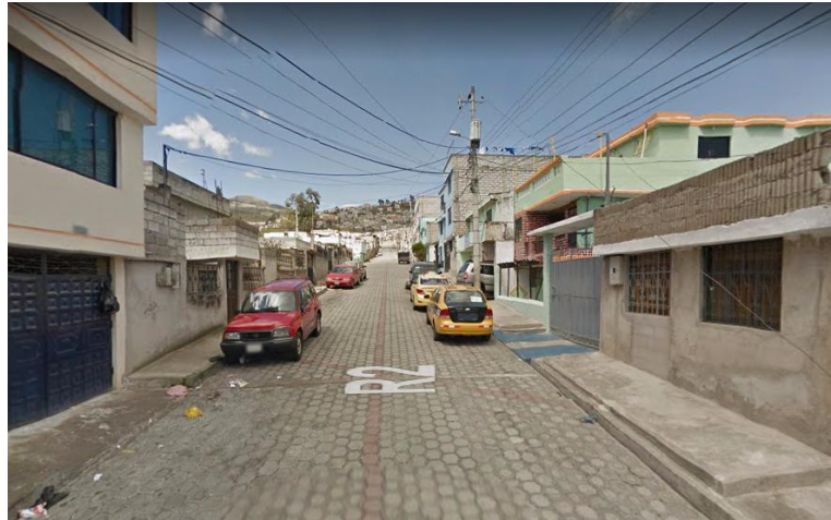
Fotografía 11: Líneas de comunicación
