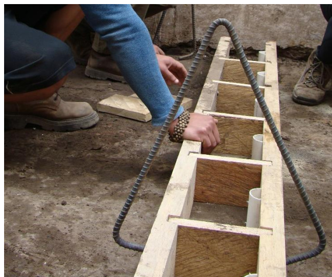
Fotografía 7: Moldes para adobes estructurales.
