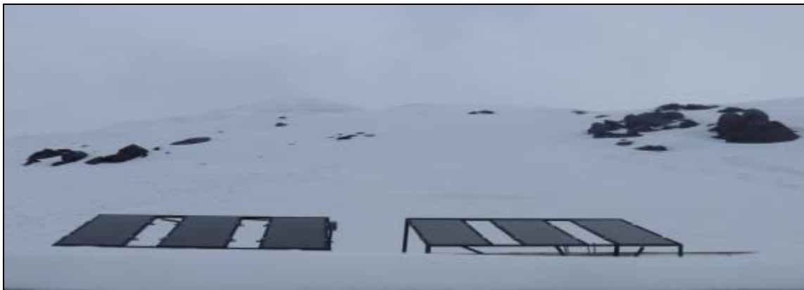
FOTO Nº 6: PANELES SOLARES DEL ÁREA
