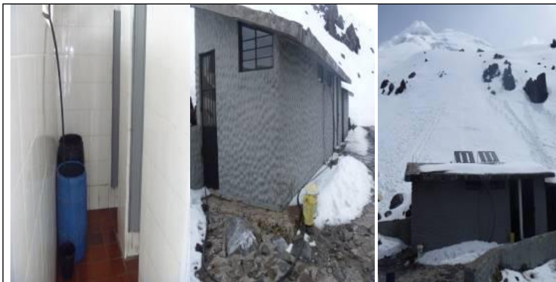
FOTO Nº 3 - 4 - 5: ÁREA DE BAÑOS
