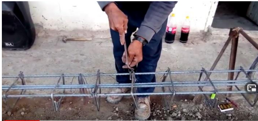
Figura XVII. Movimientos repetitivos de los armadores de columnas y estribos
