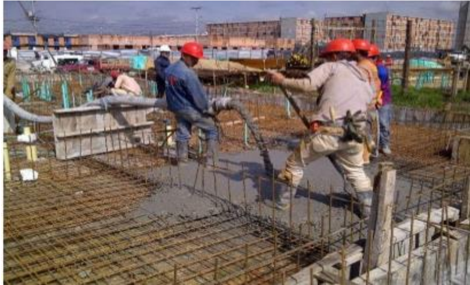
Figura V. Levantamiento manual de carga-2
