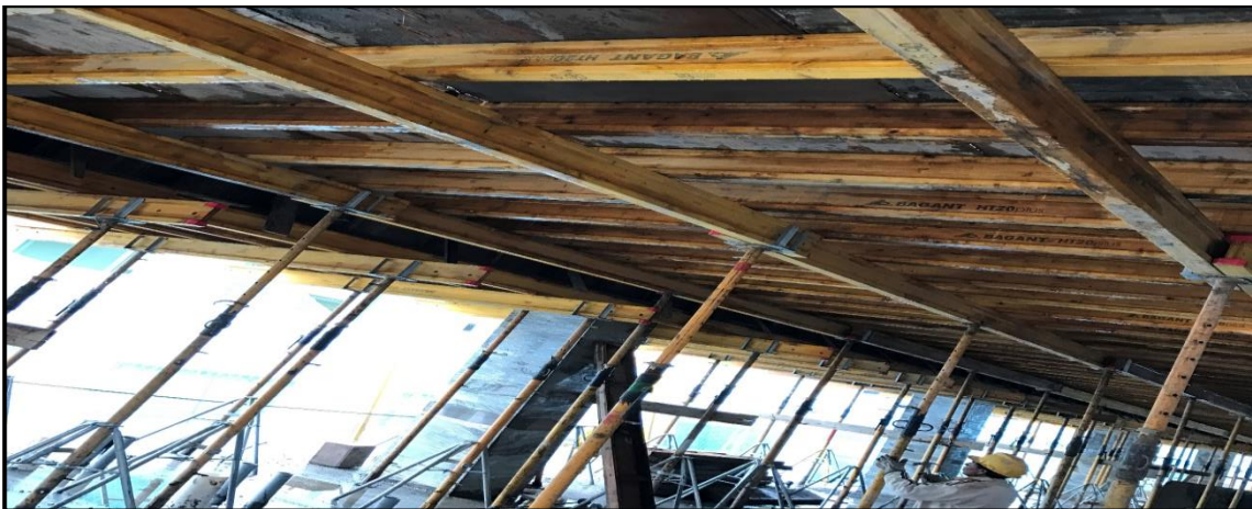
Fotografía 10: Elementos del Sistema ENKOFLEX o Losaflex.
