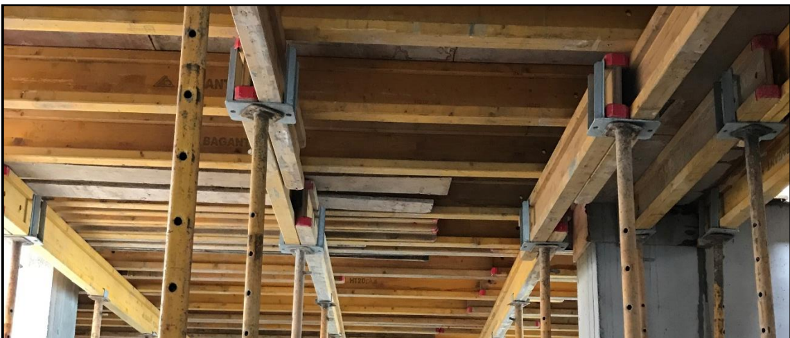
Fotografía 13: Cabezal doble VR. Colocados sobre el puntal y en la junta de dos vigas VM 20.
