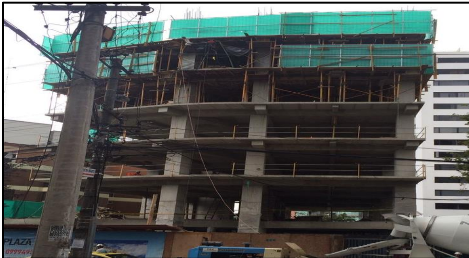
Fotografía 16: Edificio A, encofrado con el sistema tradicional.
