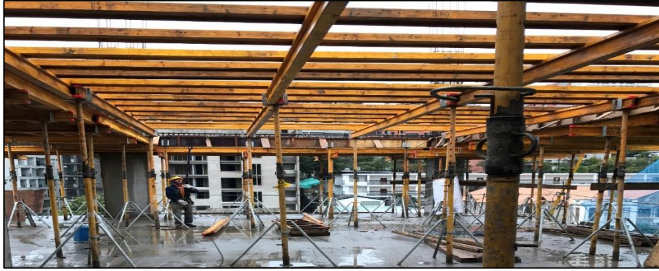
Fotografía 30: Colocación de las vigas de la segunda tramada.
