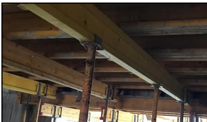
Fotografía 14: Cabezal simple VR. Colocados sobre los puntales, en zonas donde no exista traslape de vigas.
