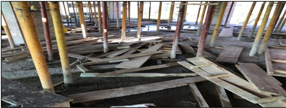
Fotografía 26: Se muestra la cantidad de desperdicios de madera después de encofrar una losa.
