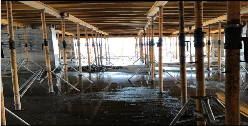
Fotografía 36: En la figura se ve la amplitud y comodidad para desplazarse por debajo de la losa encofrada.
