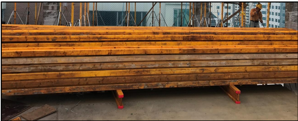
Fotografía 11: Vigas VM 20 de 5.90 metros de longitud.
