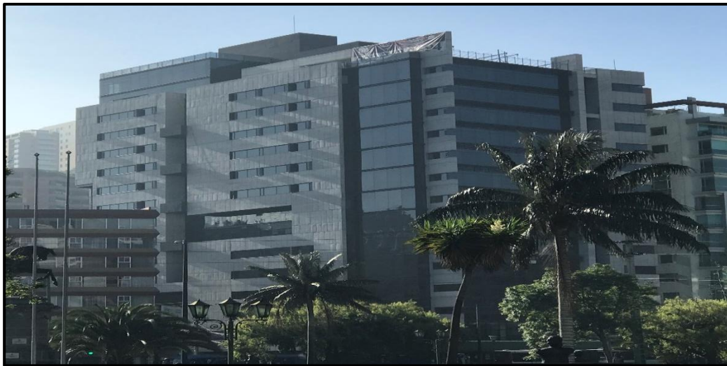
Fotografía 17: Edificio B, encofrado con el sistema LosaFlex.
