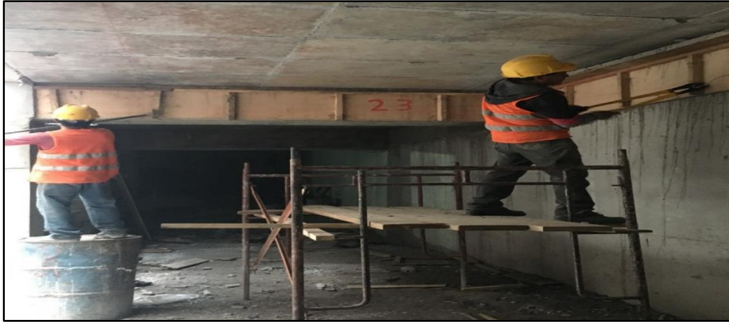
Fotografía 24: En esta imagen se puede ver el desencofrado de los tableros laterales de vigas.
