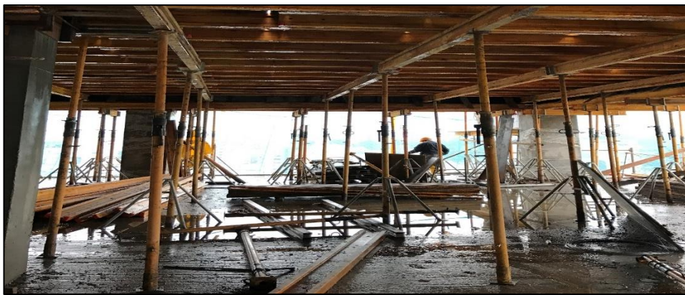
Fotografía 32: El proceso del reapuntalamiento fue finalizado, se puede ver en los puntales intermedios.
