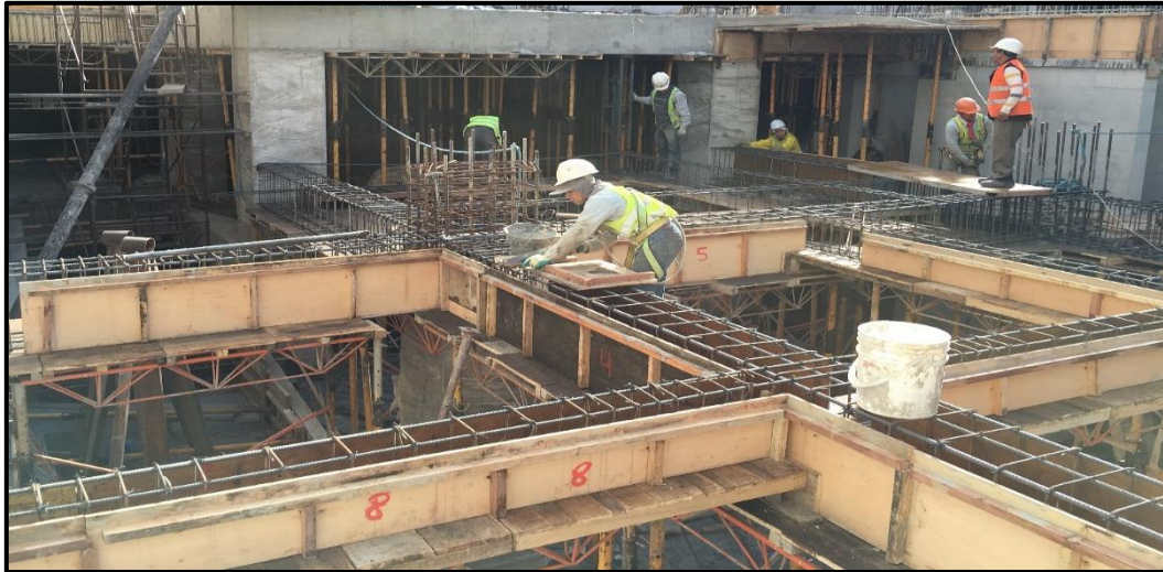
Fotografía 8: Tableros laterales para vigas descolgadas.
