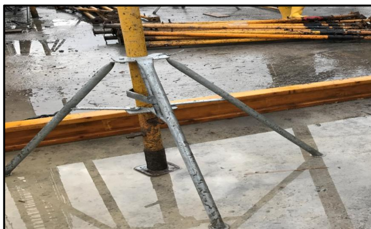
Fotografía 15: Trípode. Colocados en la base de los puntales.
