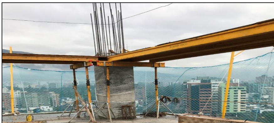
Fotografía 33: Encofrado de vigas descolgadas.
