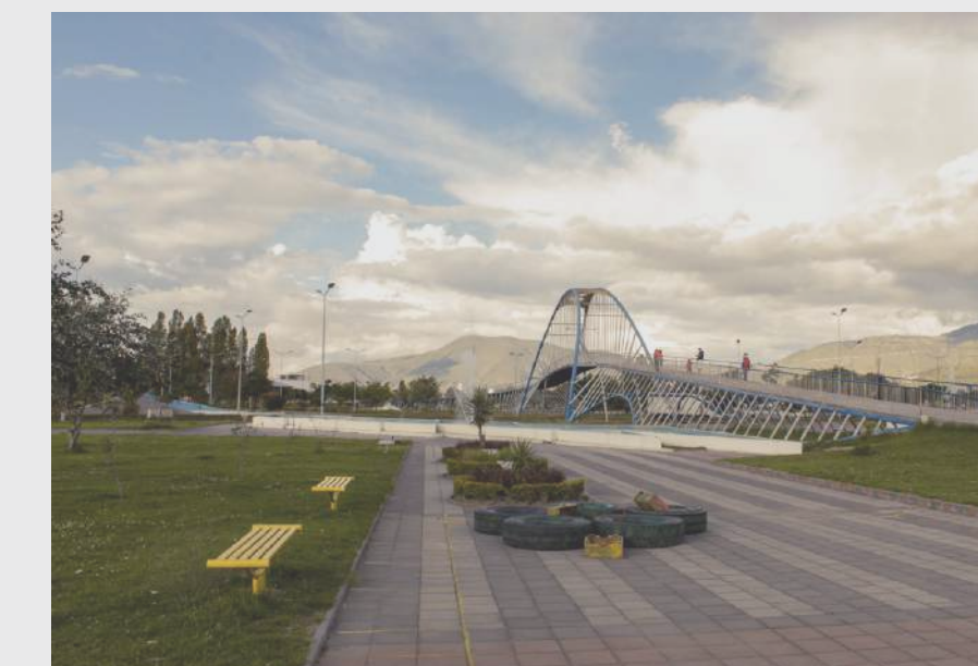
Figura 11: Puente peatonal Parque Ciudad Blanca Fuente: Elaboración propia
