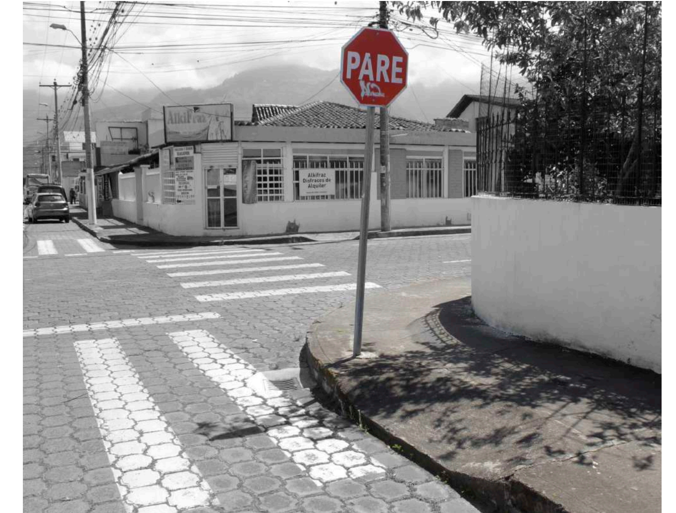
Figura 72: Rampa con pendiente excesiva y escalón Fuente: Elaboración propia
