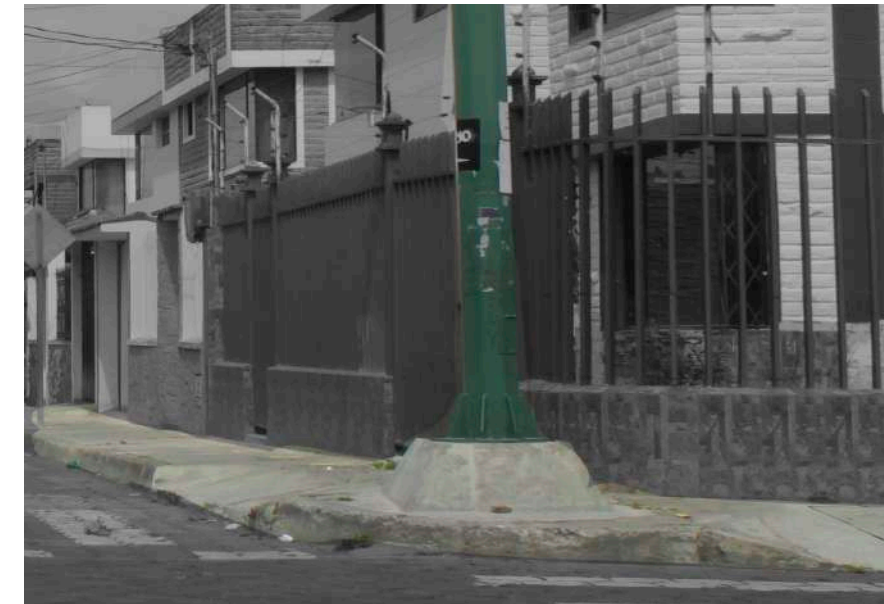
Figura 73: Rampa con pendiente Excesiva Fuente: Elaboración propia
