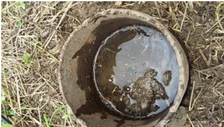
Figura 5. Prueba de Infiltración. Lote 2
