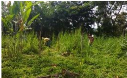
Figura 22. Limpieza de terreno
