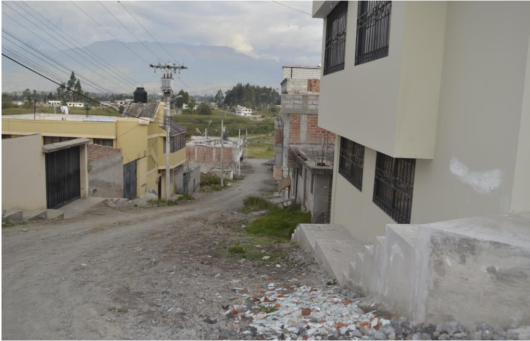
Figura 23: Estado de vías actual en el sector San Antonio de Padua
