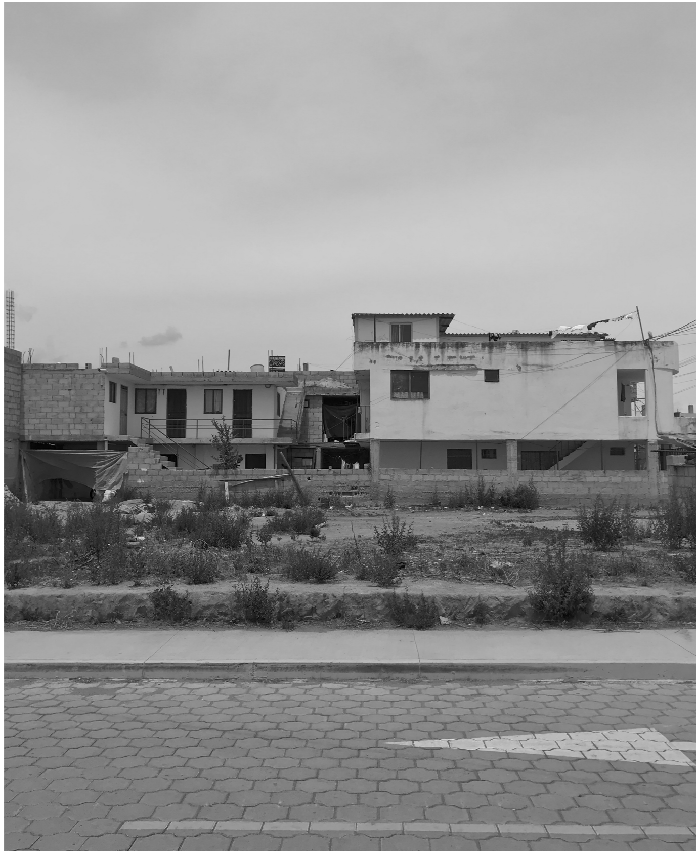
Figura 34. Viviendas existentes del barrio "Nueve de Febrero"
