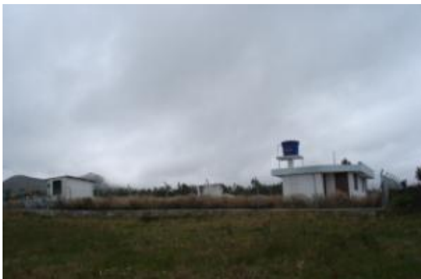
Fotografía N°4. Planta de Tratamiento “Los Corrales” – 3454 msnm
