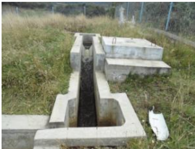
Fotografía N° 5. Cajón de Ingreso Vertedero Trapezoidal (Mezcla Rápida) – 3454 msnm
