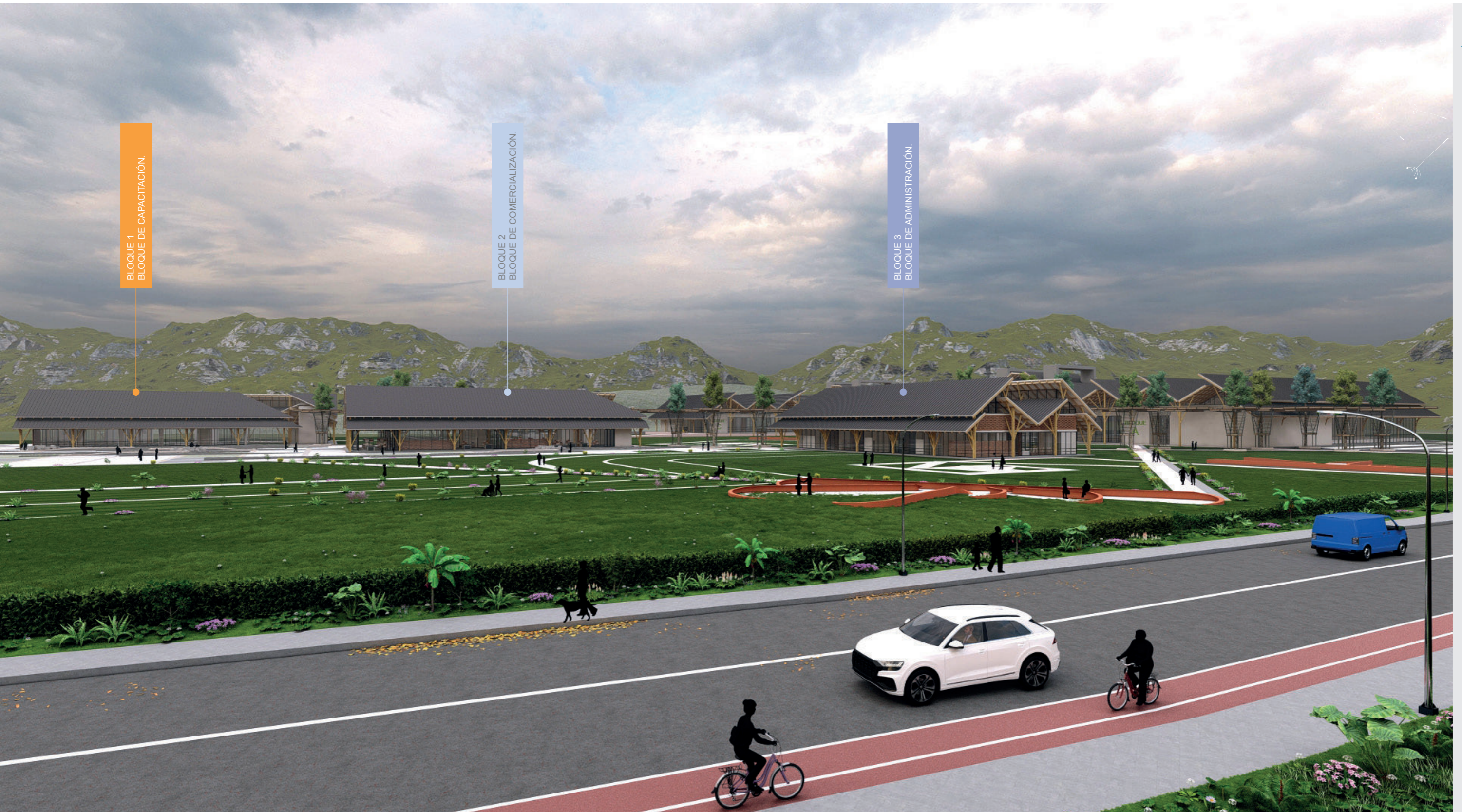
Figura 119. Vista general bloques sociales 1,2,3 Fuente: Delgado, Núñez (2021)
