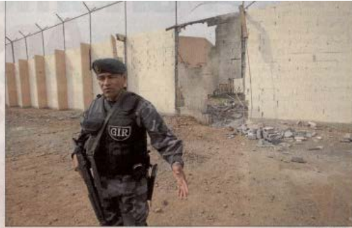
En los exteriores de 'La Roca'. Explosivos dejaron la pared destruida, en un intento fuga.
