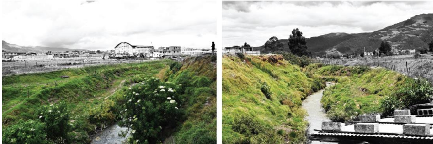
Quebrada El Timbo, estado actual.
