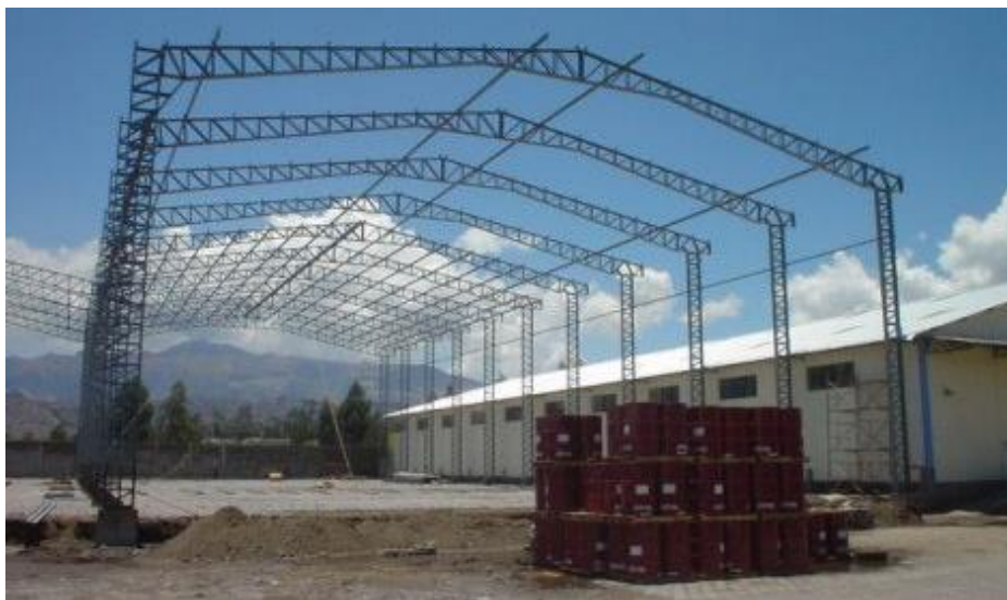
Figura 1.2 Estructura del galpón en la actualidad Fuente: Aring Construcciones
