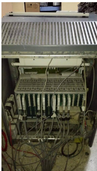
Gráfico N° 4: Central Telefónica Omnipcx 4400 reverso
