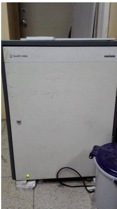
Gráfico N° 3: Central Telefónica Omnipcx 4400 Anverso
