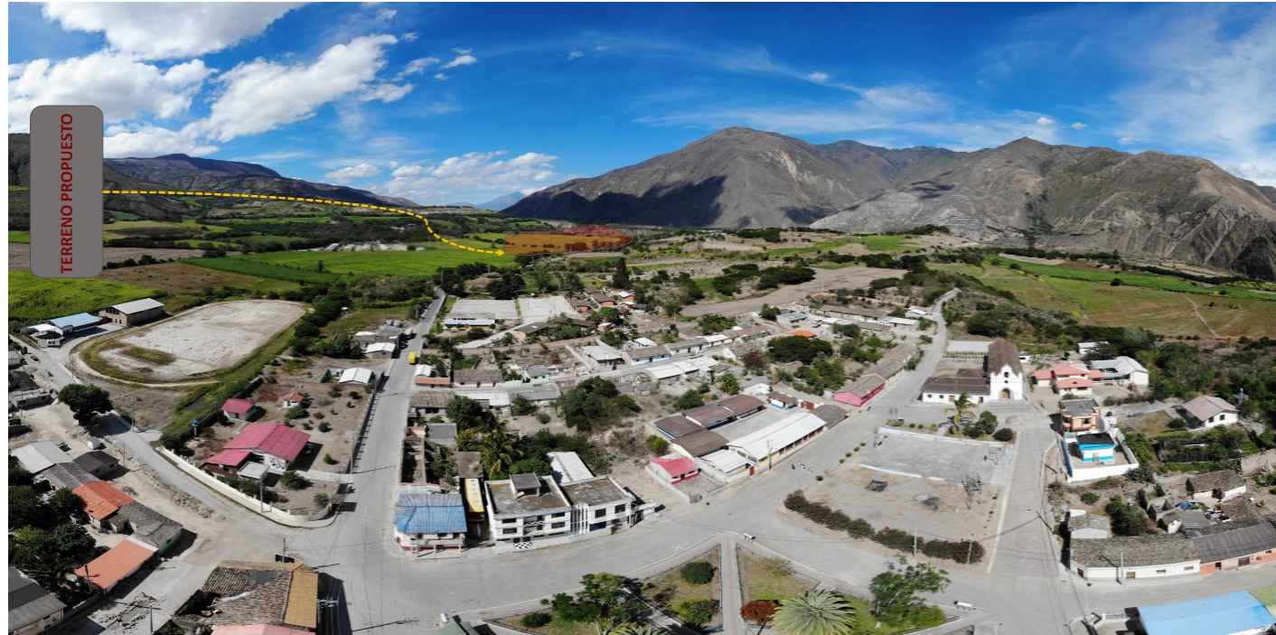
Ilustración 37: Vista del terreno desde la Concepción
